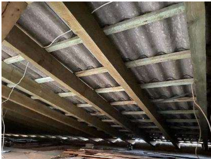
Bild 10: Dachstuhl mit Faserzementplatten-Eindeckung
