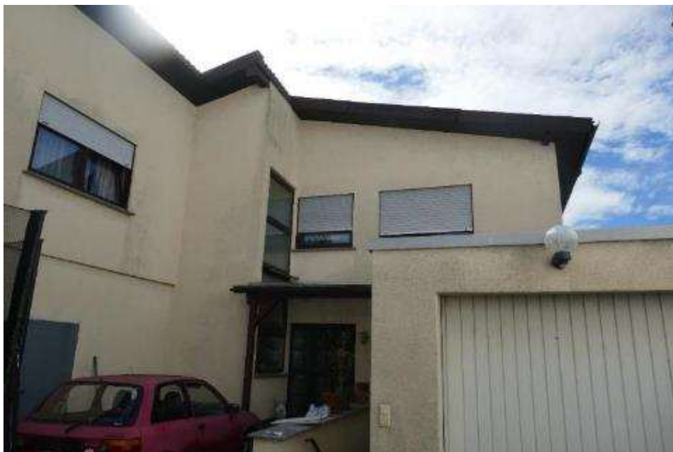
Bild 1: Hauptgebäude mit Ansicht von Norden
