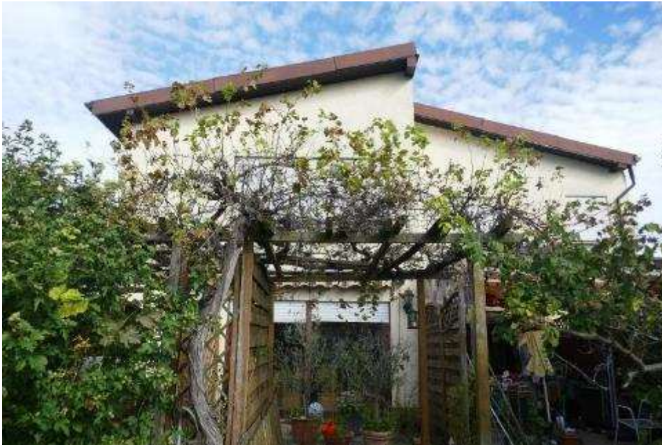
Bild 3: Gebäudeansicht von Süden
