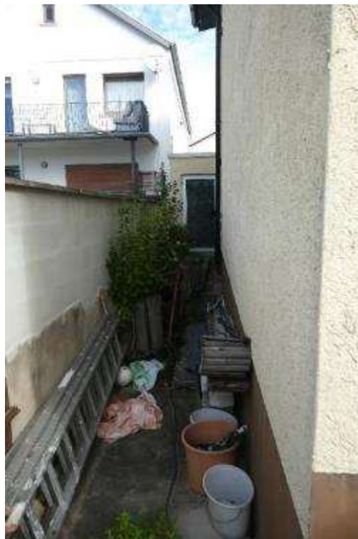
Bild 12: Bauwuch auf der Gebäude-Westseite
