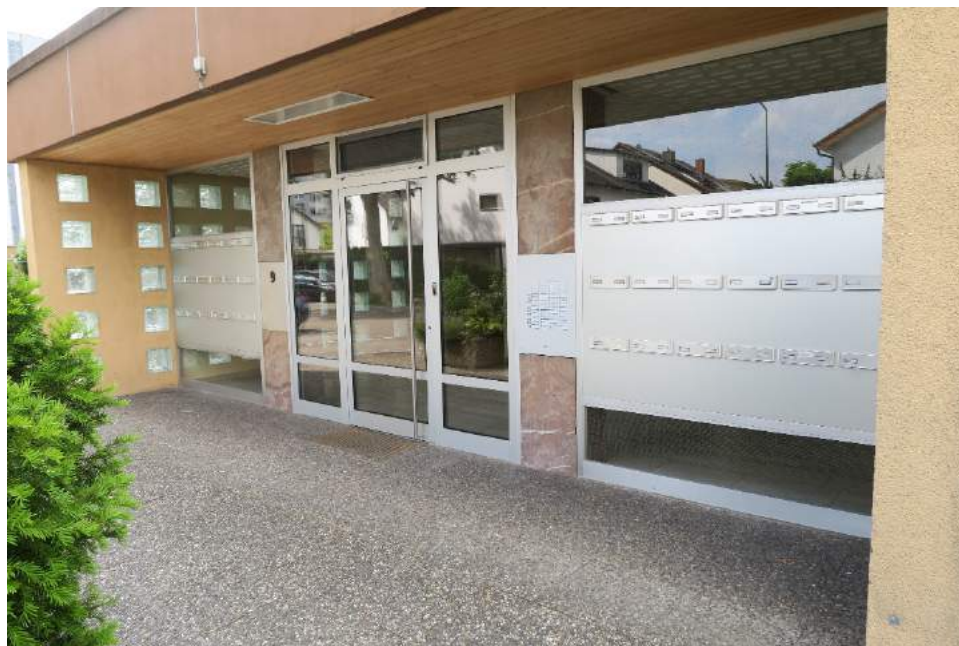
Bild 5: Hauseingang der Gesamtanlage
