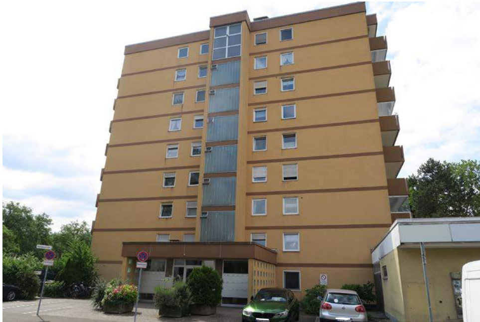
Bild 1: Straßenansicht der Gesamtanlage
