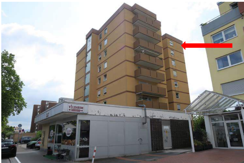
Bild 2: Straßenansicht der Gesamtanlage mit Kennzeichnung der Lage des Bewertungsobjekts
