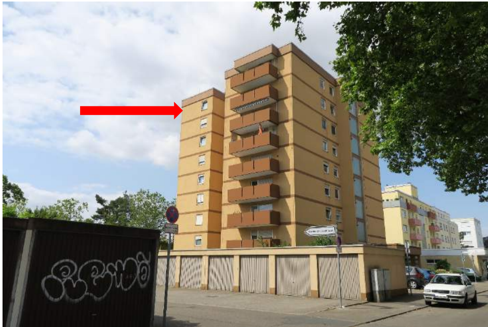
Bild 3: Straßenansicht der Gesamtanlage mit Kennzeichnung der Lage des Bewertungsobjekts
