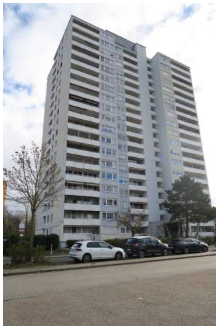
Bild 2: Straßenansicht der Gesamtanlage
