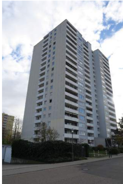
Bild 3: Straßenansicht der Gesamtanlage
