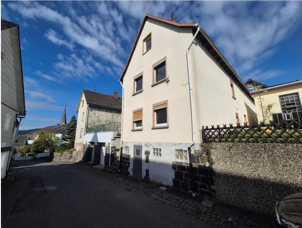
Beschreibung:01 Wohngebäude straßenseitig
