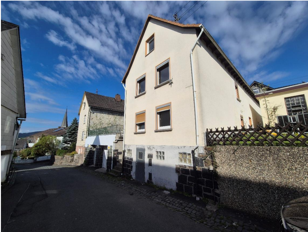
Beschreibung:01 Wohngebäude straßenseitig
