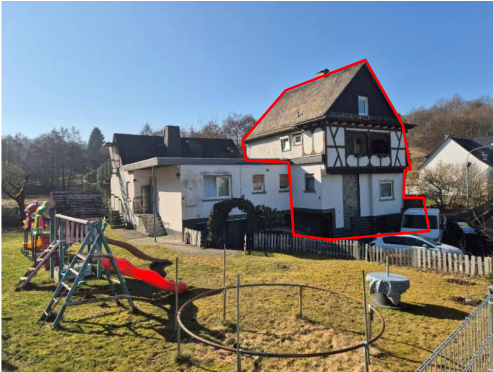
Beschreibung:01 Wohngebäude straßenseitig
