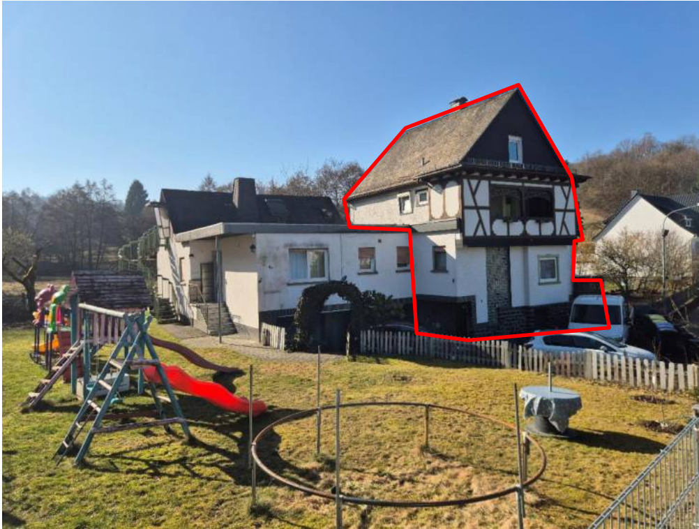
Beschreibung:01 Wohngebäude straßenseitig
