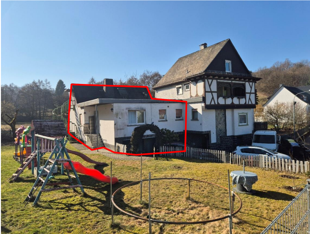
Beschreibung:01 Wohngebäude straßenseitig
