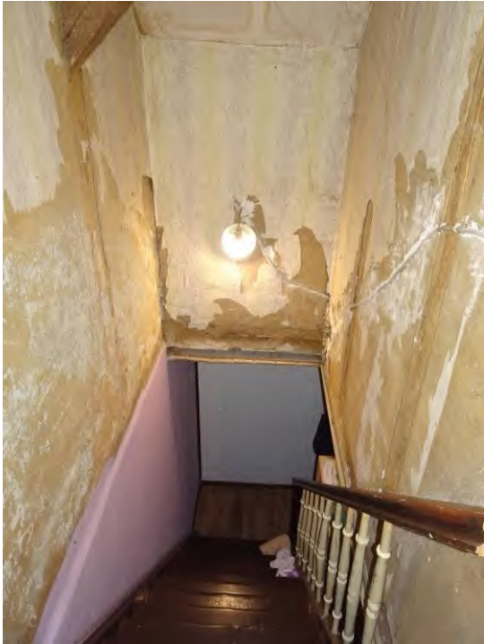
Treppe zwischen Ober- und Dachgeschoss
