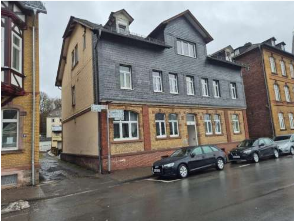
Beschreibung:02 Wohngebäude seitlich Bild 3
