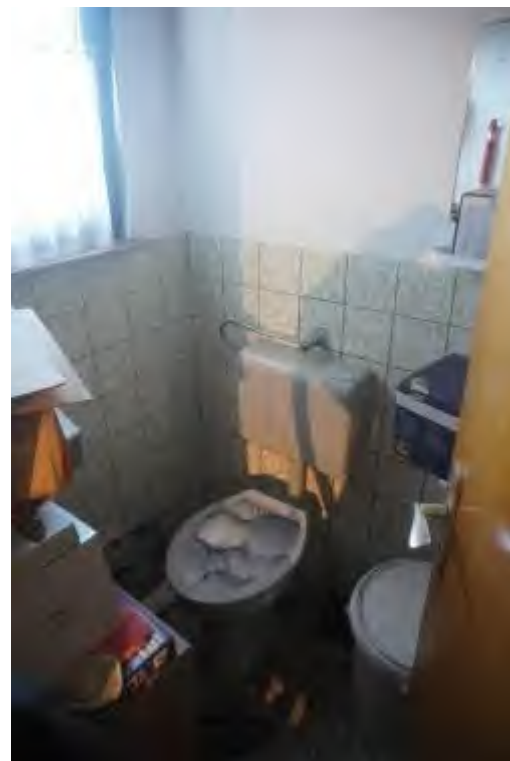
WC im südlichen Anbau
