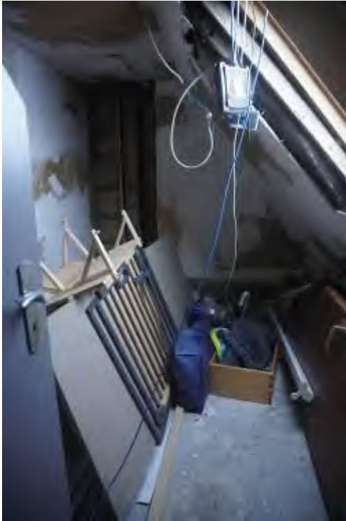
Dachboden nicht ausgebaut
