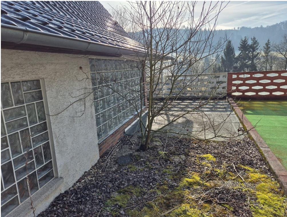
Beschreibung:03 Wohngebäude Terrasse
