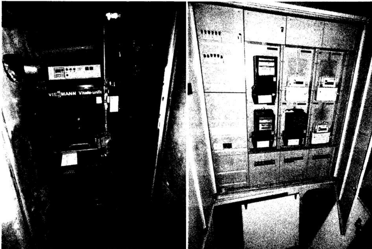
Wärmeerzeuger vermutlich Baujahr 1994 Herstell-Daten 751 502 6 4 0 198 010 5
