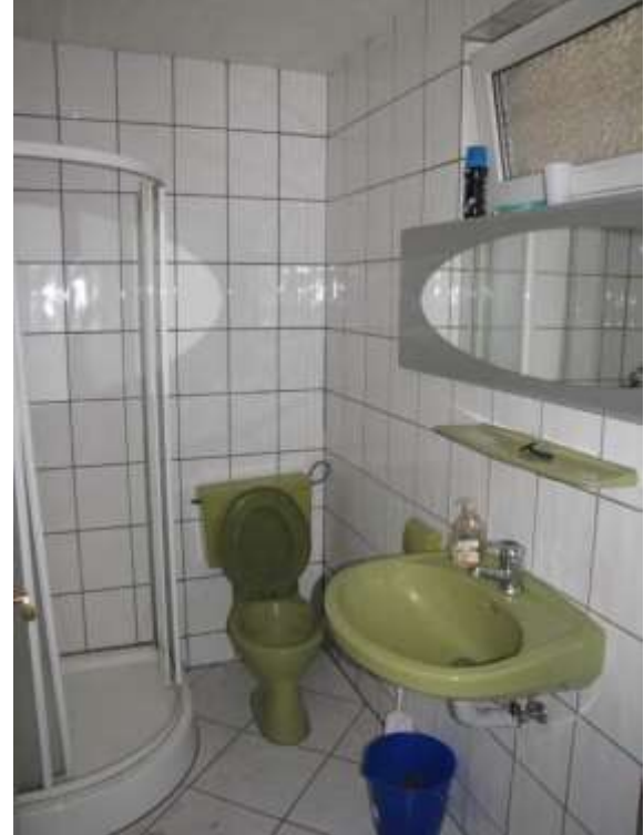
WC und Dusche im Erdgeschoss, Nordostseite (2012)
