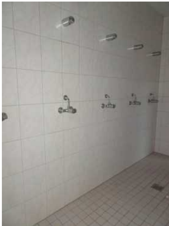
Duschen ehemaliger Fitnessbereich
