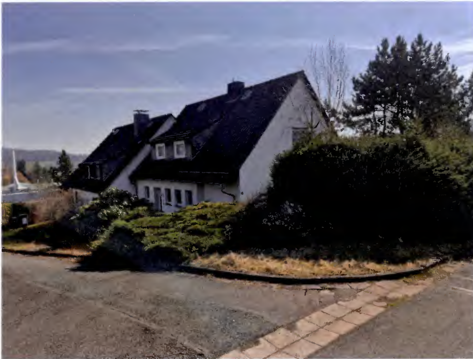
Beschreibung: 01 Wohngebäude straßenseitig
