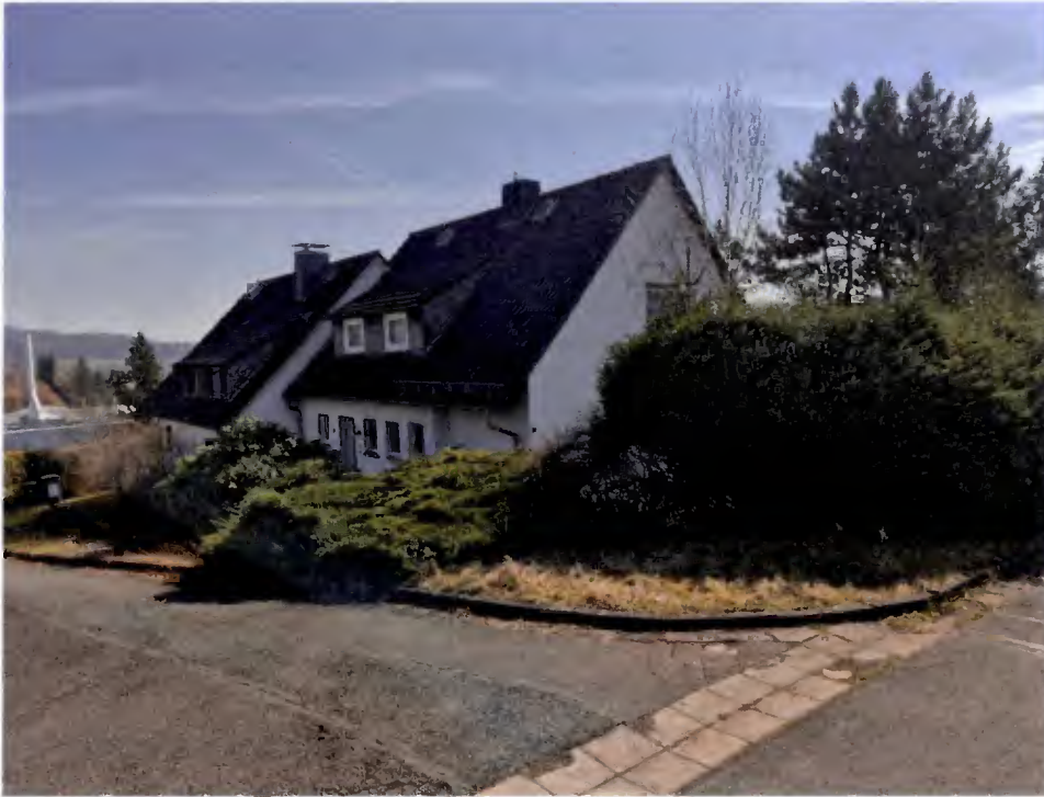
Beschreibung: 01 Wohngebäude straßenseitig
