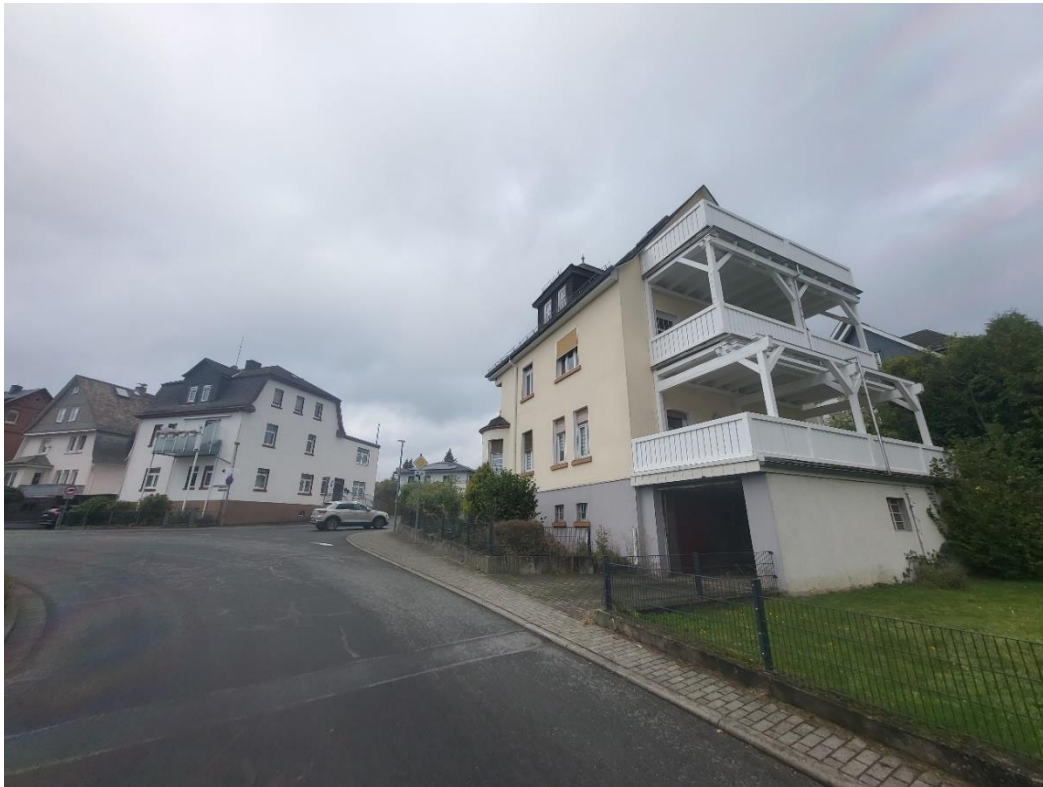
Beschreibung:03 Wohngebäude mit Garage
