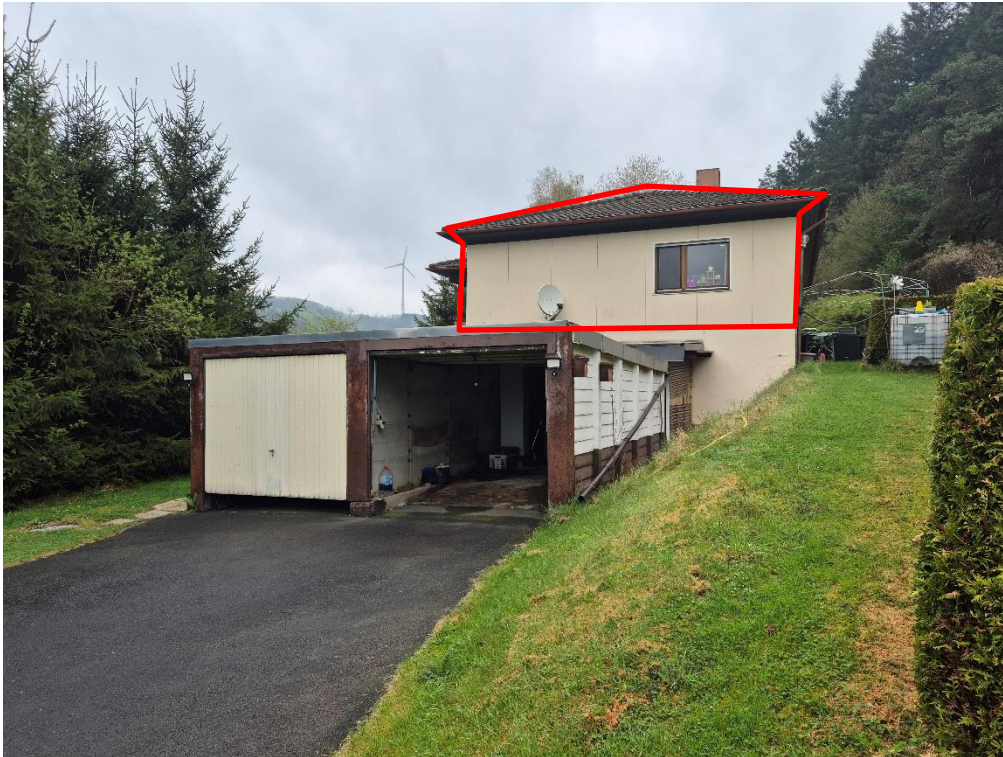
Beschreibung:01 Wohngebäude mit Garage
