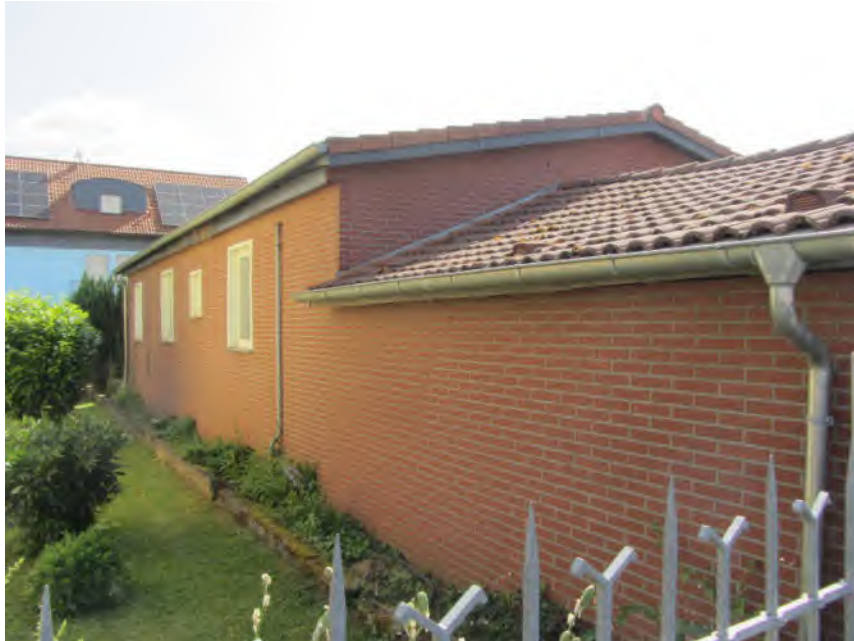
Bild 3: Ansicht Nordwest (Nachbargrundstück)
