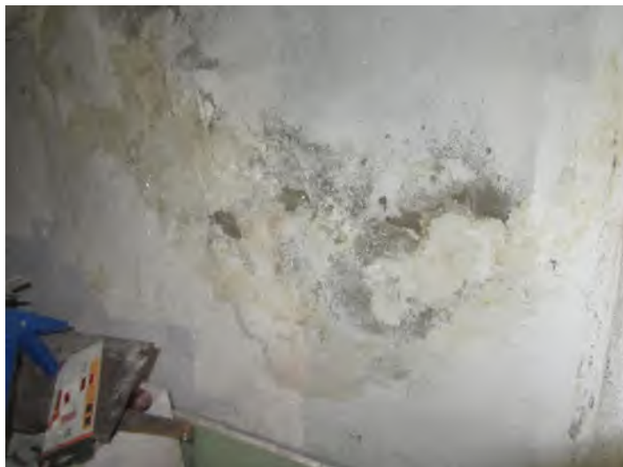
Bild 32: Feuchte Kellerwände
