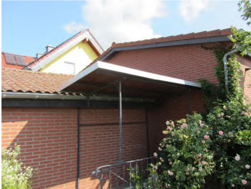
Bild 35: Überdachung der Kellertreppe
