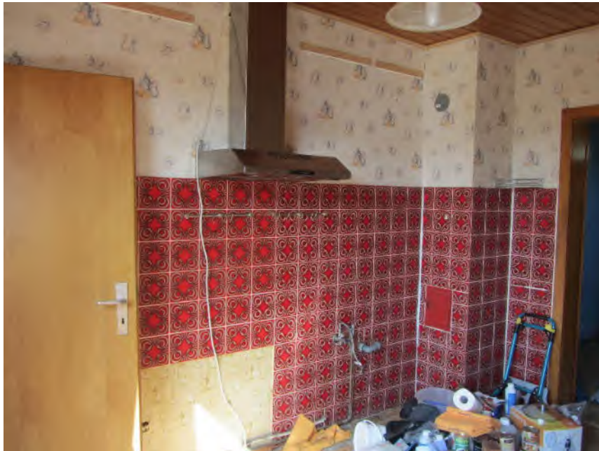
Bild 25: Wohnung 2, Küche als Durchgangszimmer
