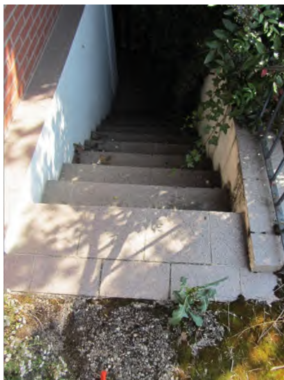
Bild 28: Außentreppe, Zugang zu Teilunterkellerung
