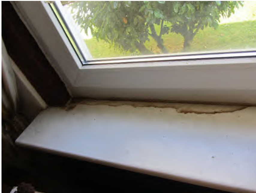
Bild 11: Wohnung 1, Zustand Fenster
