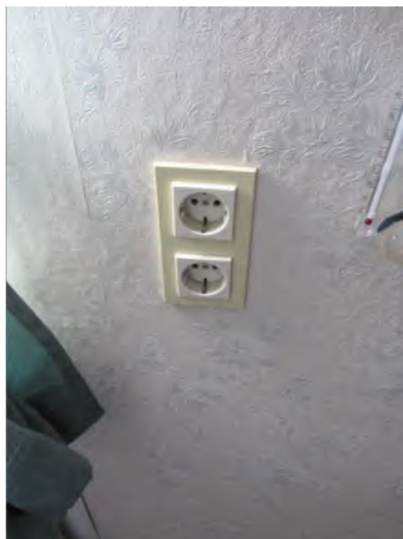
Bild 10: Wohnung 1, Zustand Elektro
