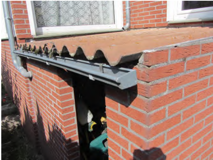
Bild 19: Abstellraum, von außen zugänglich
