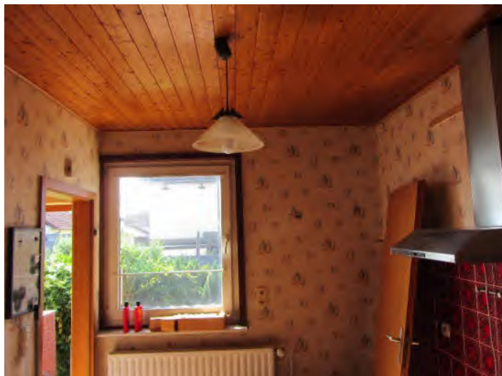
Bild 24: Wohnung 2, Küche als Durchgangszimmer
