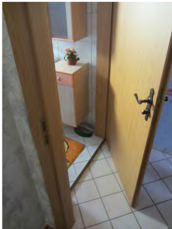
Bild 18: Wohnung 1, Zustand Innentüren
