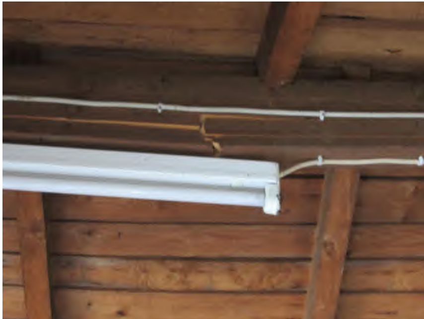
Bild 39: Gebrochener Firstbalken in der Garage
