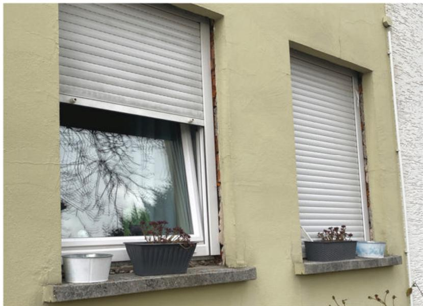
**Abb. 5:** Foto des SV; z.T. unvollständige Fensteranschlüsse
