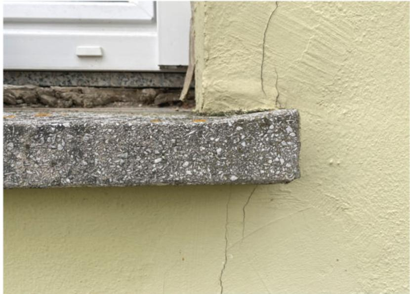
**Abb. 4:** Foto des SV; z.T. Putzrisse der Fassade, unvollständige Fensteranschlüsse
