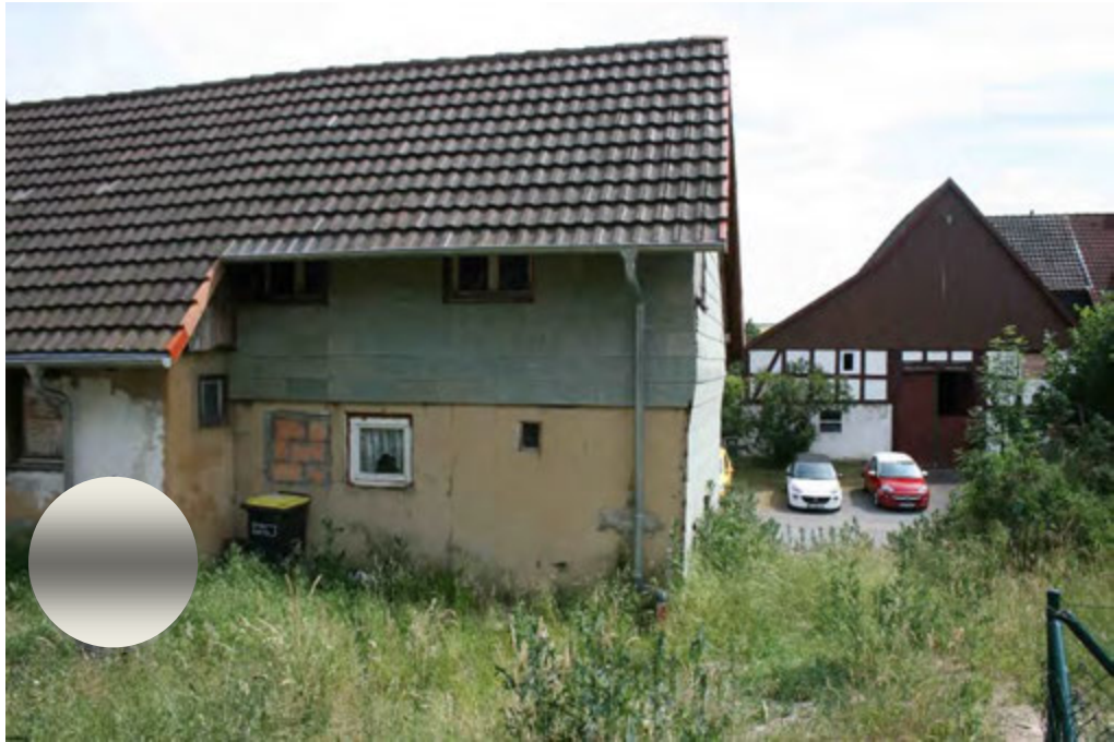
Bild 1 / Flurstücke 84 und 85, Gebäuderückseite Nord, Blick zur Waldstraße
