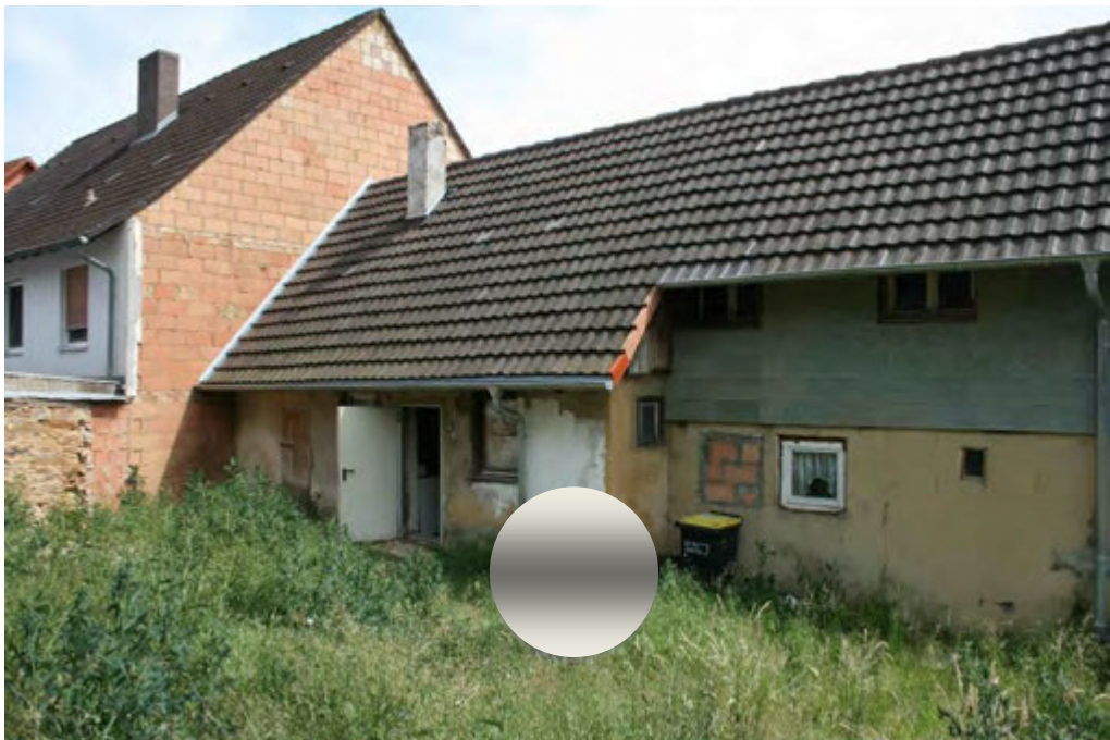
Bild 2 / Flurstücke 84 und 85, Gebäuderückseite Nord, links Nachbargebäude
