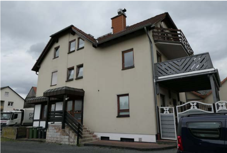
Bild 1 | Ansicht von Westen
