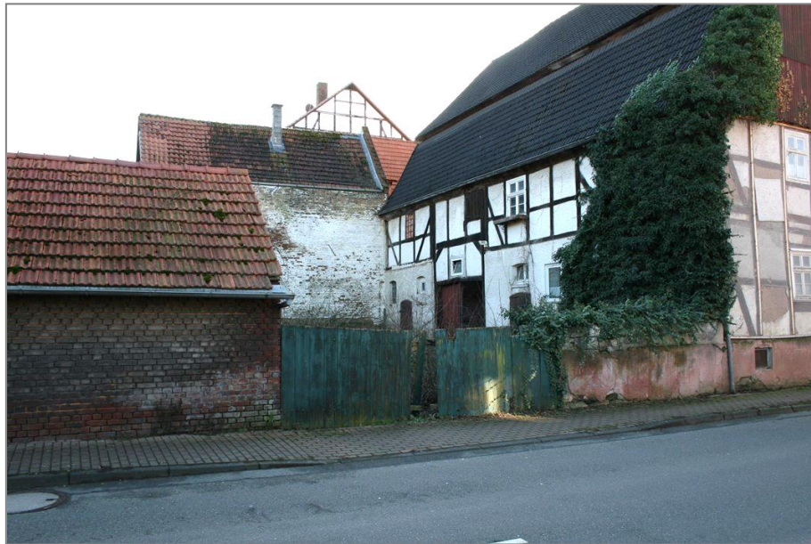
Bild 3 / Ansicht Nord _ Zufahrt Hof _ Nebengebäude
