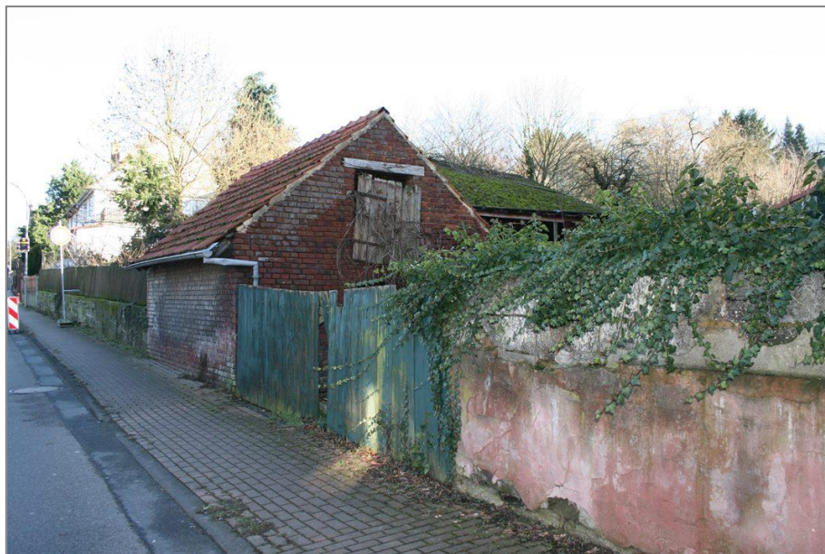
Bild 4 / Ansicht Nord _ Zufahrt Hof _ Mauereinfriedung Grundstück (hinter den Nebengebäude)
