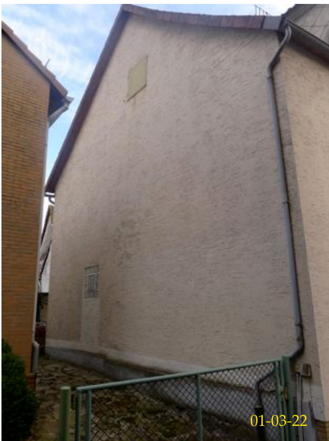
Giebelwand von Norden
