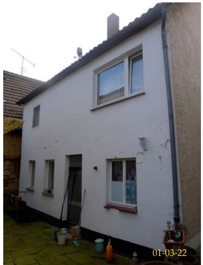
Außenwand Hofseite (von Nord-Osten)
