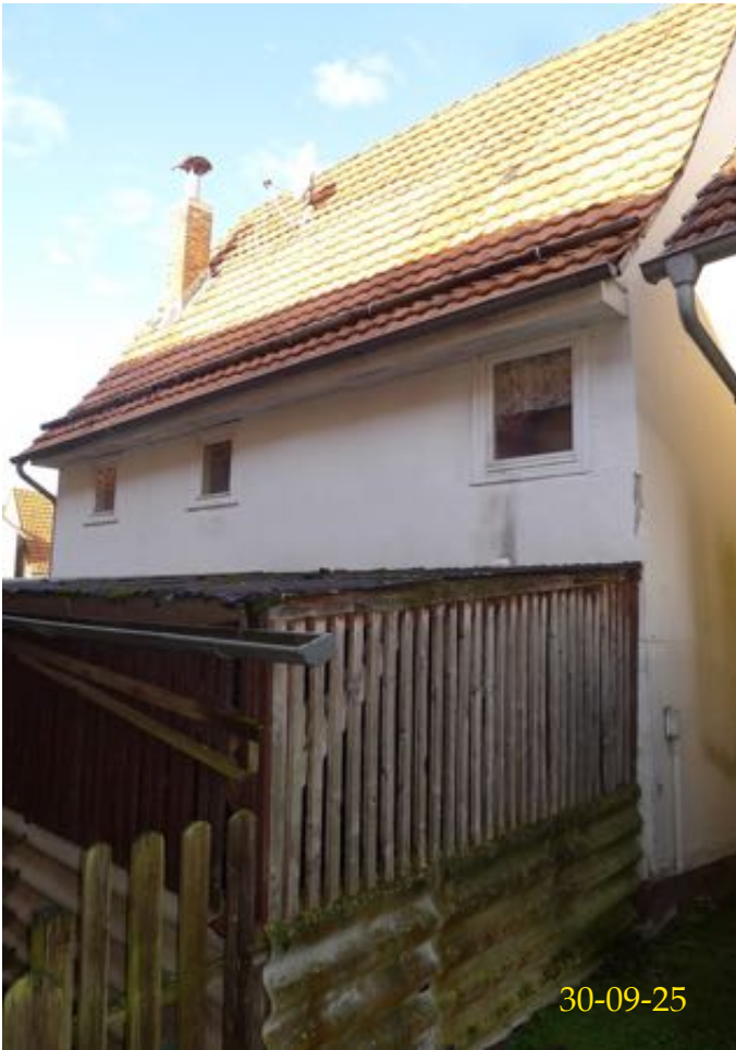
Ansicht von Süd-Osten
