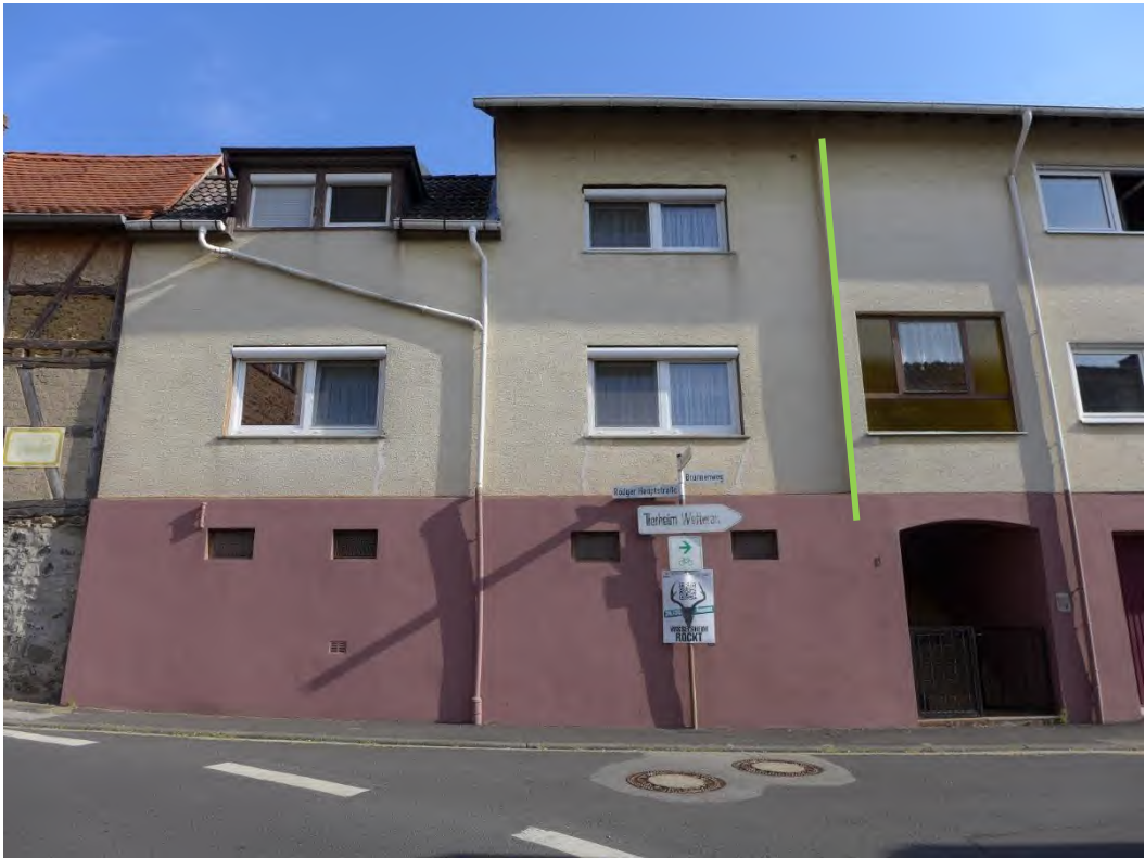
4 Frontansicht (Südansicht) Altbau (links bis zur grünen Linie)
