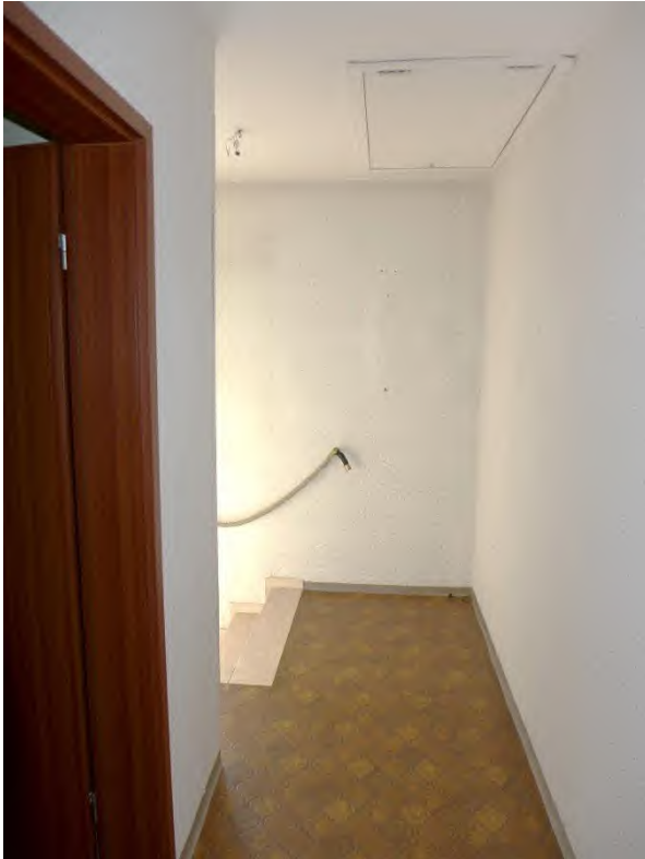
15 a Zustand Zimmer Wohnhaus 1975
