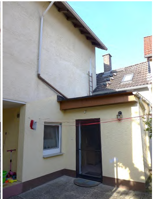
6 b Hauseingang Altbau
