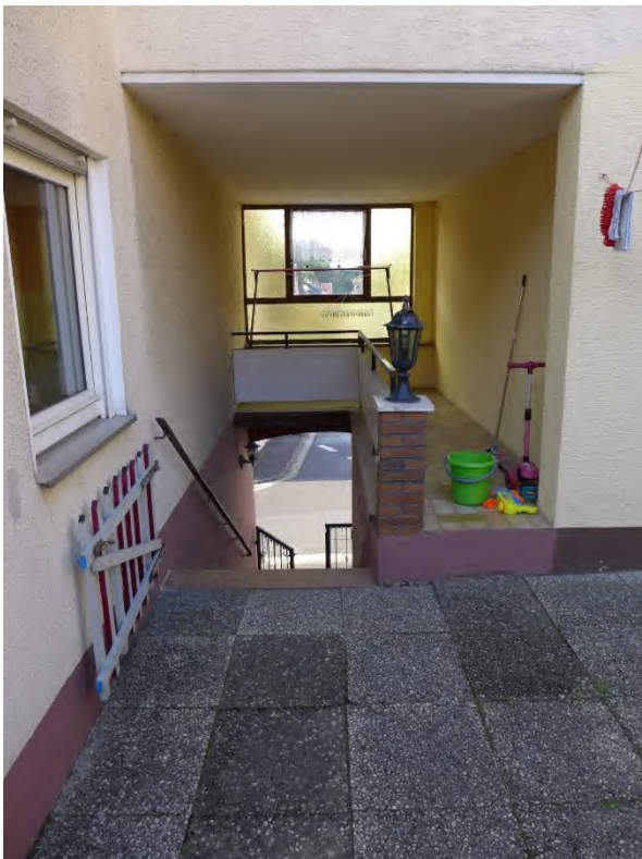
6 a Hauszugangstreppe von der Straße
