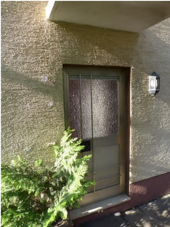
7 a Eingangstür Wohnhaus 1975
