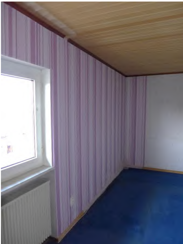
16 a Zustand Zimmer Wohnhaus 1975
