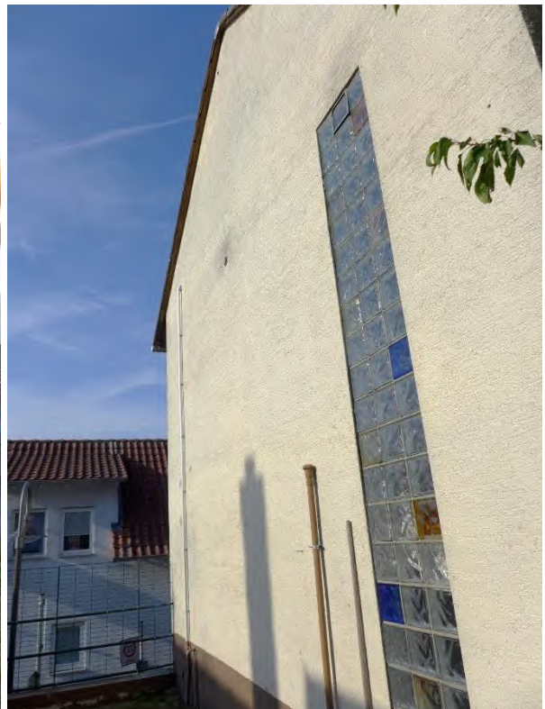
8 b Seitenansicht (Nordostansicht Haus 1975)
