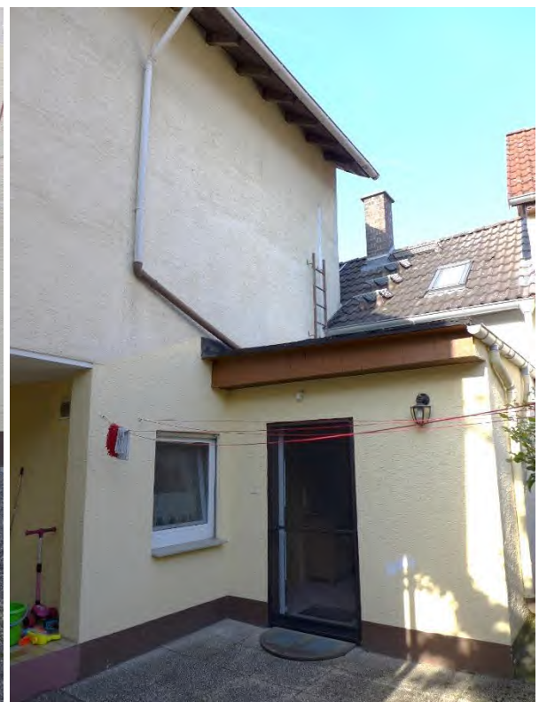
6 b Hauseingang Altbau
