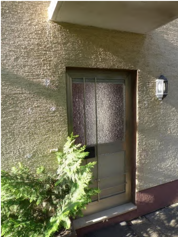
7 a Eingangstür Wohnhaus 1975
