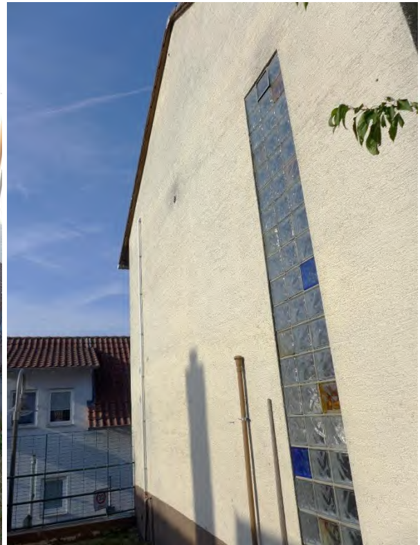
8 b Seitenansicht (Nordostansicht Haus 1975)
