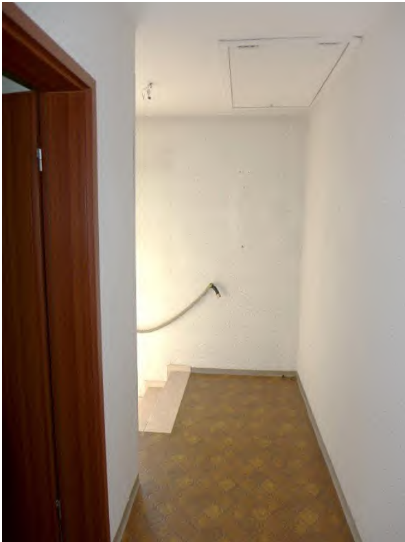
15 a Zustand Zimmer Wohnhaus 1975
