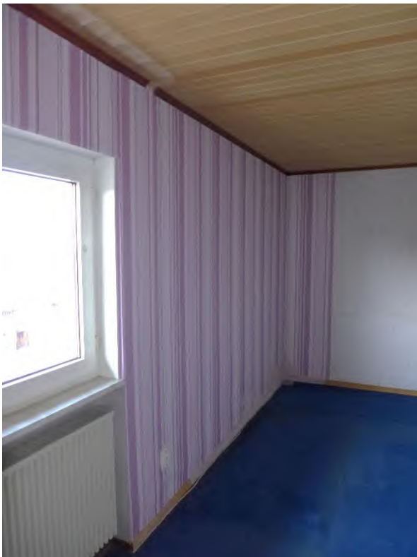
16 a Zustand Zimmer Wohnhaus 1975
