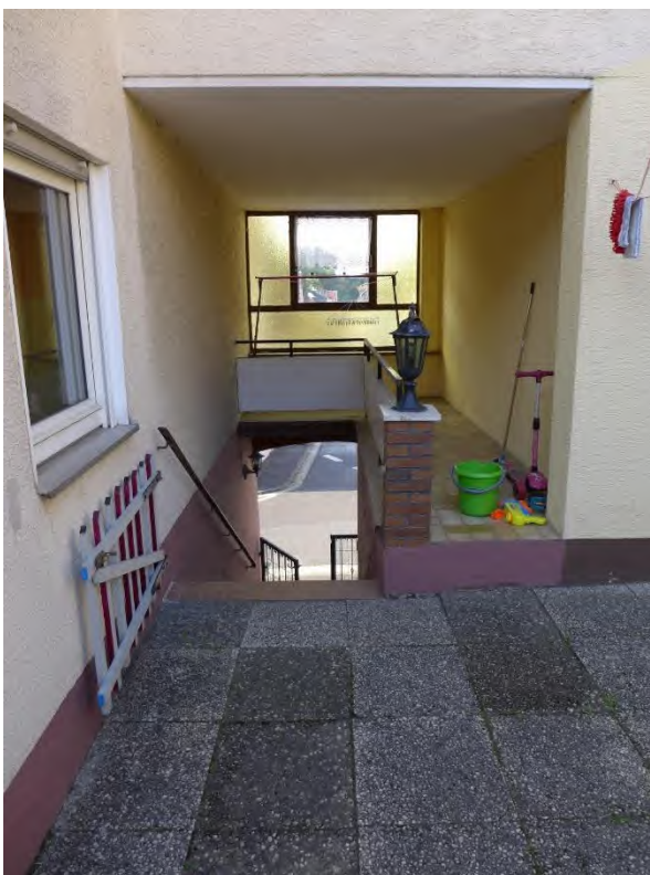
6 a Hauszugangstreppe von der Straße
