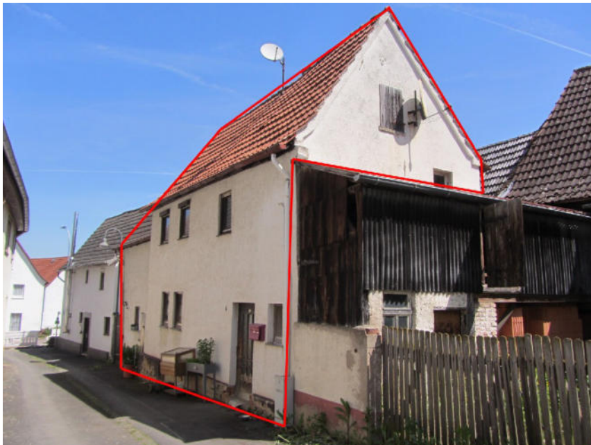
Bild 2: Ansicht "Hermannseck", Hauptgebäude im Vordergrund
