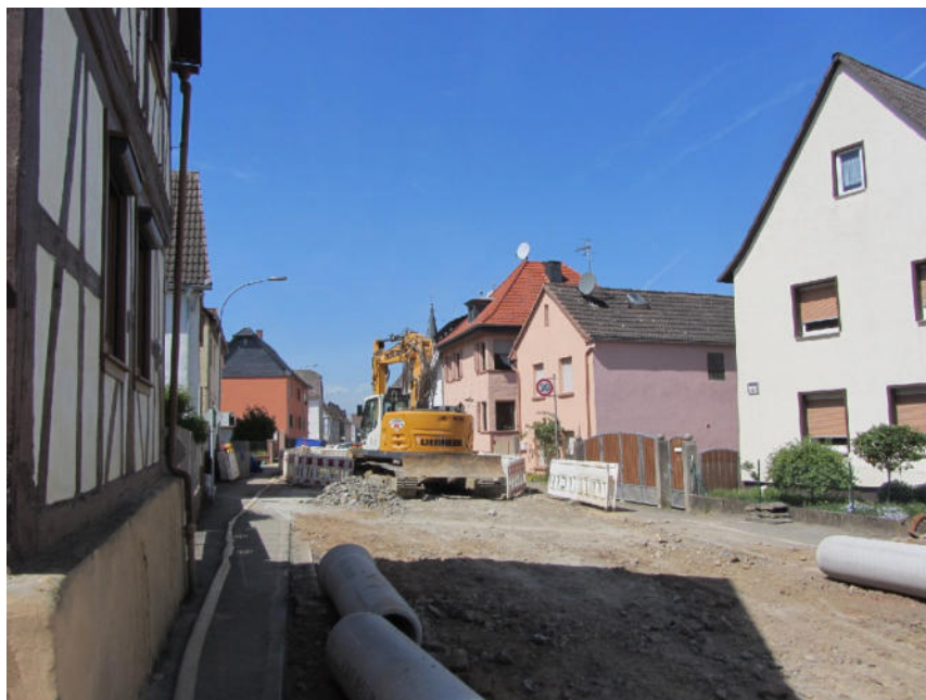
Bild 12: Straßensanierungsarbeiten Erbstädter Straße
