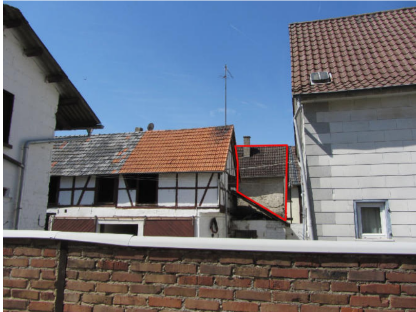
Bild 3: Einsehbarer Bereich der Ost-Fassade
