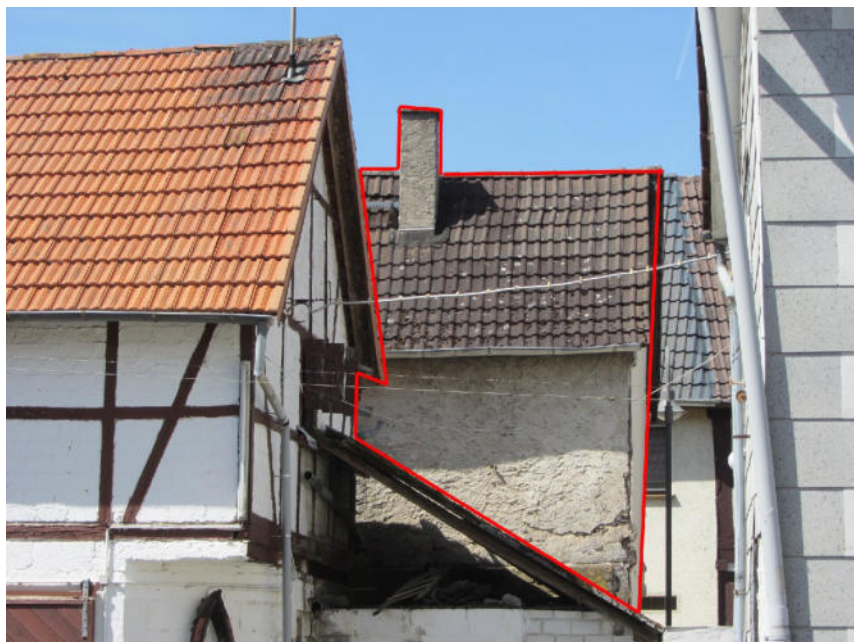
Bild 4: Einsehbarer Bereich der Ost-Fassade
