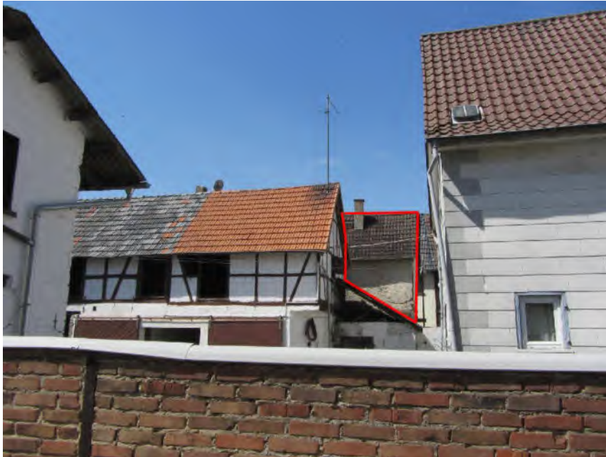
Bild 3: Einsehbarer Bereich der Ost-Fassade
