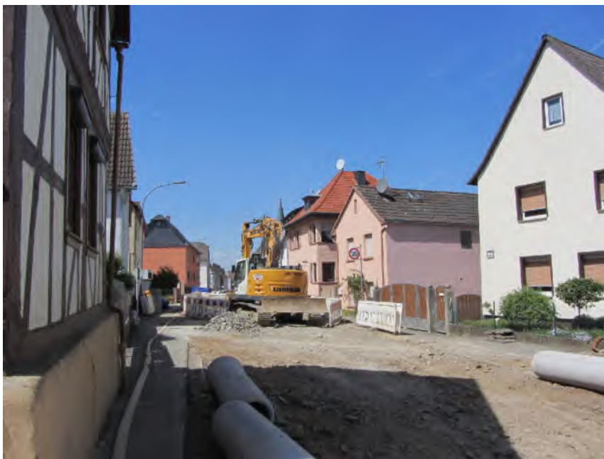
Bild 4: Straßensanierungsarbeiten Erbstädter Straße
