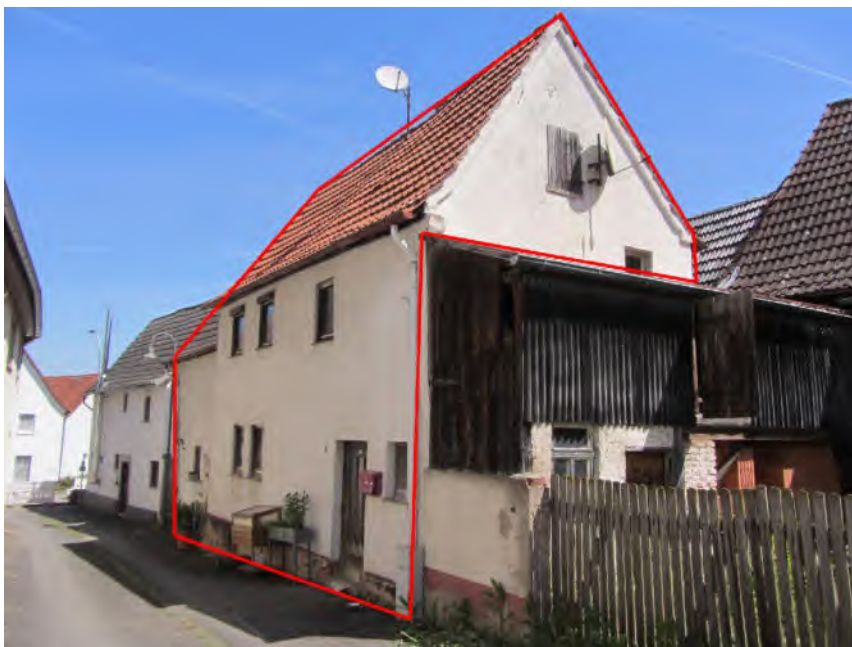
Bild 2: Ansicht "Hermannseck", Hauptgebäude im Vordergrund
