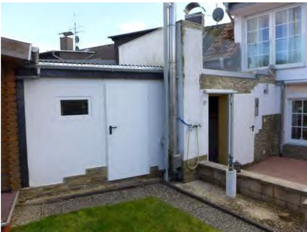
6 Anbau Abstellraum und Heizung
