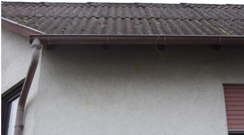
Bild 7: Anbau: Zustand Dacheindeckung (Welleternit) ggf. Asbesthaltig
