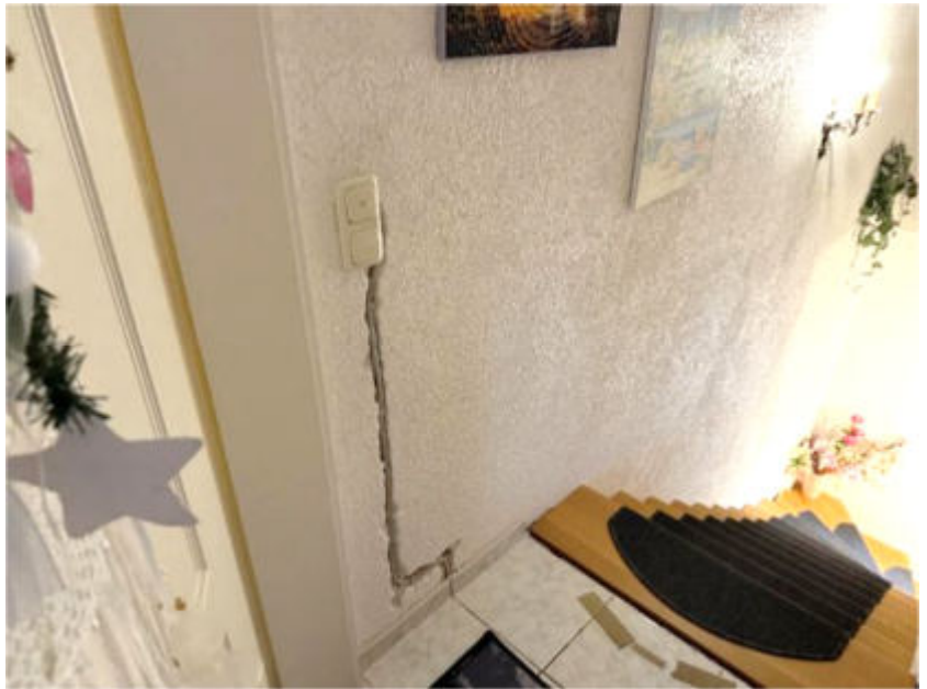
Abb. 12: Foto des SV; z.T. offener Elektroinstallationsschlitz (DG, Vorbereich/Treppenhaus)
