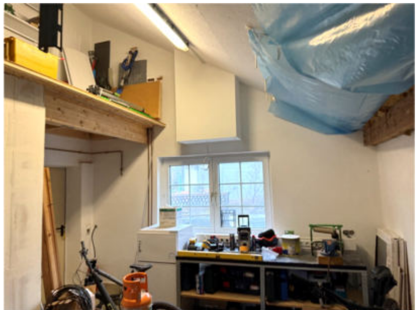
Foto 16 des SV: Abstellraum (ehem. Garage), Zugang Garten (links)
