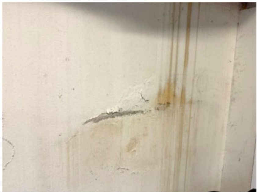
Abb. 3: Foto des SV; z.T. Feuchteschäden in Grenzwandbereichen des Abstellraums (ehem. Garage)
