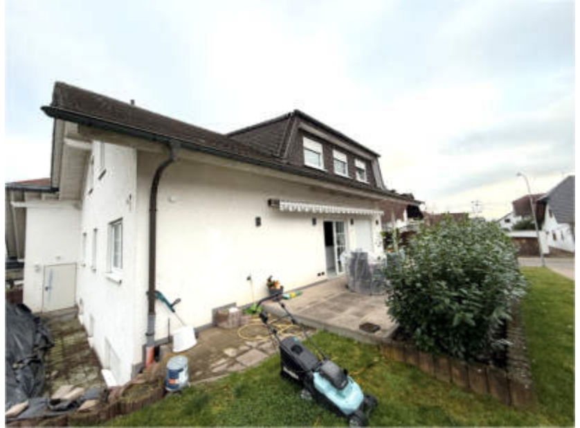
Foto 3 des SV: Ansicht von Nordwesten, Terrasse EG
