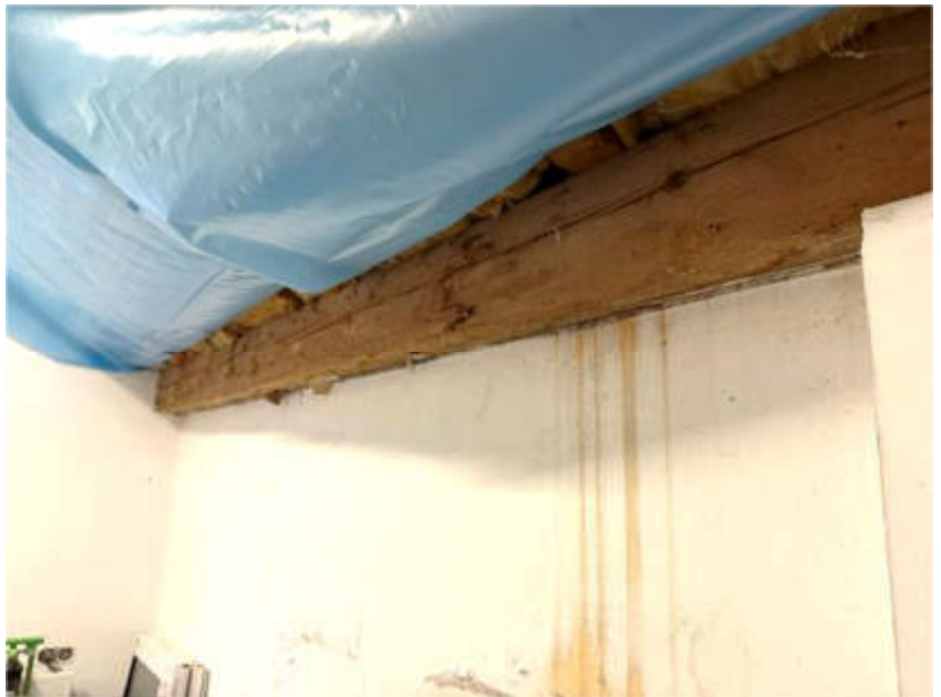
Abb. 5: Foto des SV; z.T. Feuchteschäden in Grenzwandbereichen des Abstellraums (ehem. Garage)
