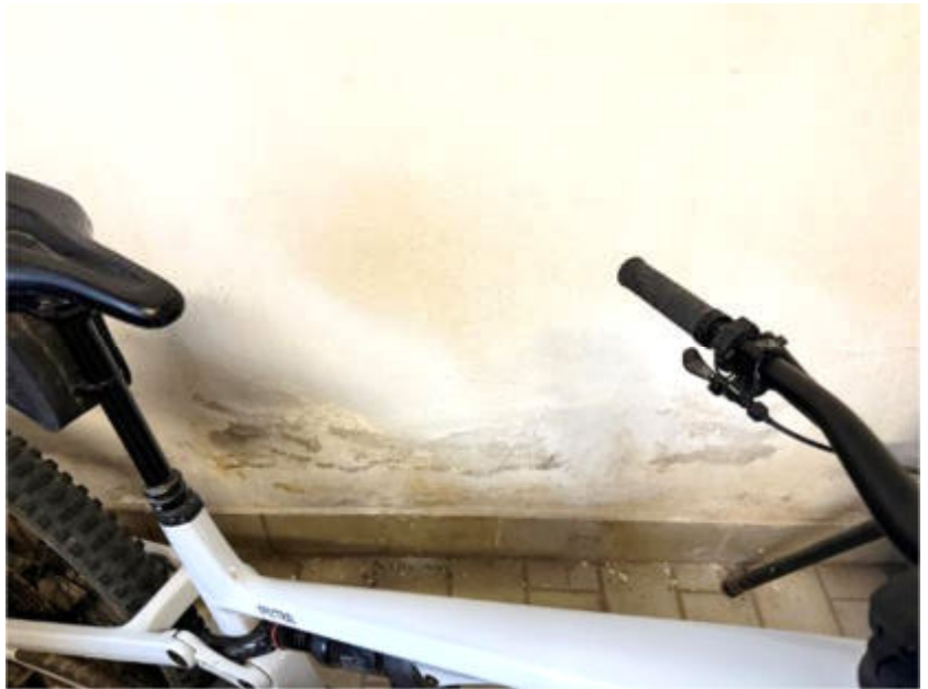
Abb. 4: Foto des SV; z.T. Feuchteschäden in unteren Grenzwandbereichen des Abstellraums (ehem. Garage)
