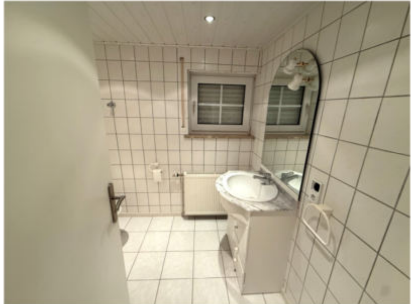
Foto 13 des SV: Kellergeschoss, Bad
