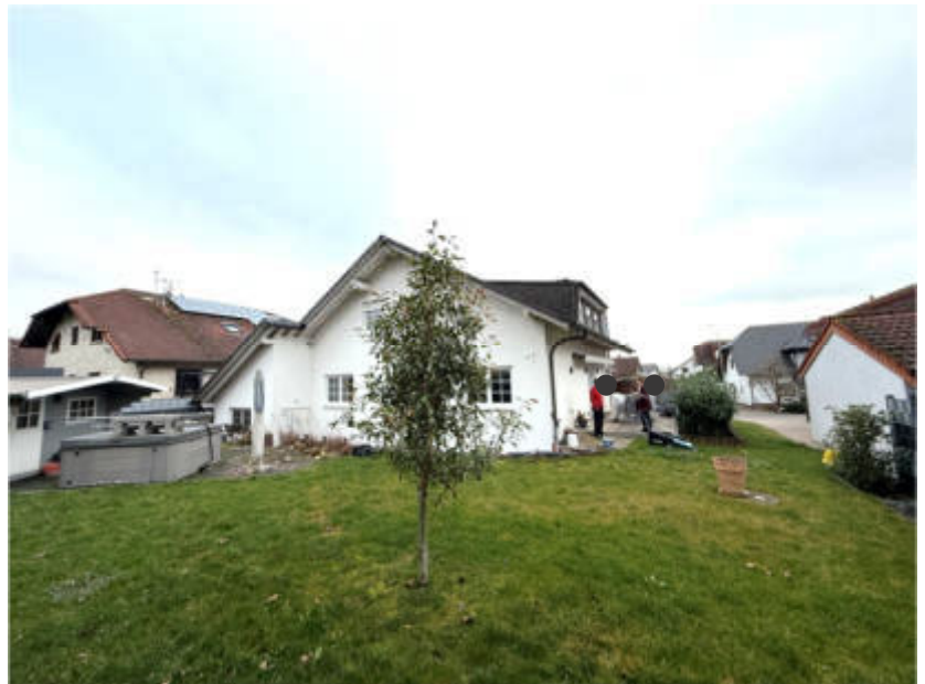
Foto 4 des SV: Ansicht von Norden; Gebäuderückseite
