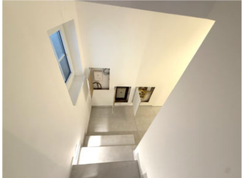
Foto 11 des SV: Wohnung Erdgeschoss; Kellerabgang
