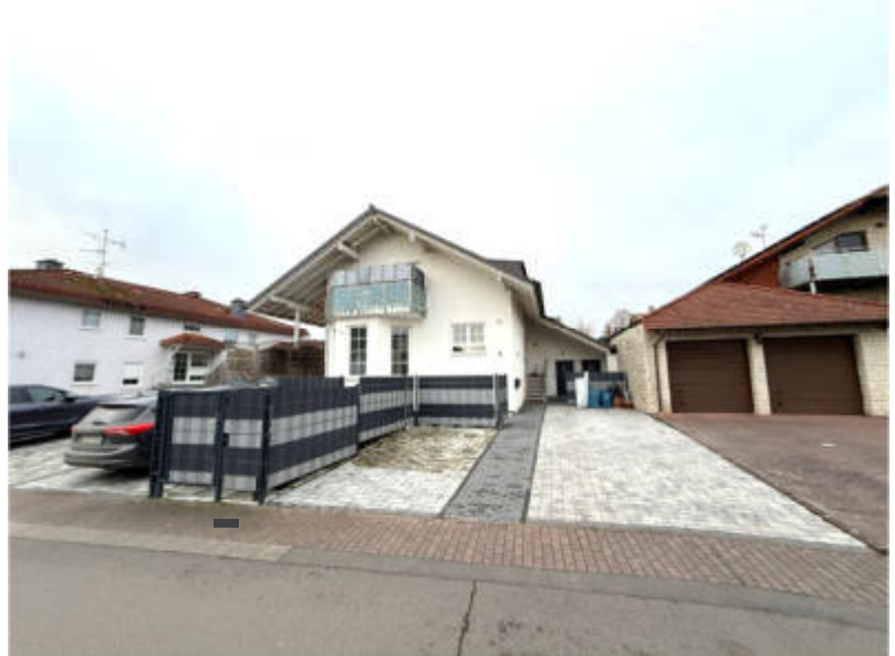
Foto 1 des SV: Ansicht von Süden; Straßenansicht (Gutenbergstraße)
