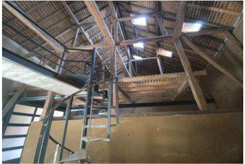
Foto 18 des SV: Ökonomie-/Gewerbegebäude, hinterer Gebäudeteil
