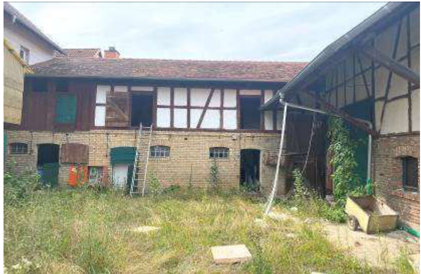
Foto 6 des SV: Ansicht Stall II / Technik von Südosten, vom Hof
