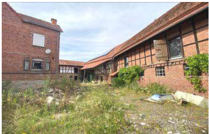
Foto 5 des SV: Ansicht Wohnhaus, Stall II/Technik und Ökonomie-/Gewerbegebäude von Osten, vom Hof aus
