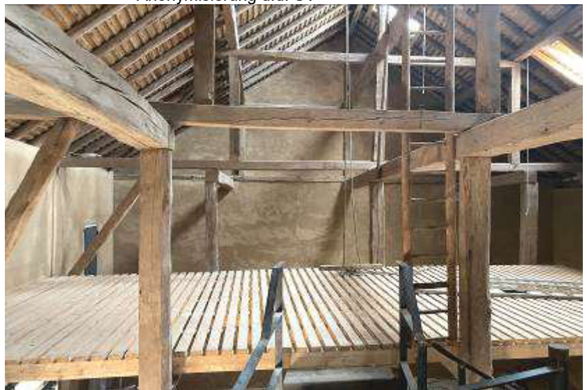
Foto 20 des SV: Ökonomie-/Gewerbegebäude, hinterer Gebäudeteil; Galeriebene OG (Heuboden)
