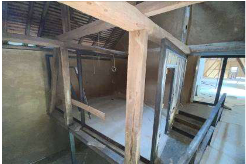
Foto 21 des SV: Ökonomie-/Gewerbegebäude, hinterer Gebäudeteil; Galerieebene OG, Büro (geplant)
