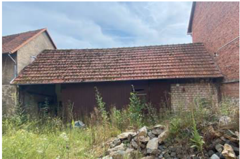
Foto 7 des SV: Ansicht Stall I von Nordosten
