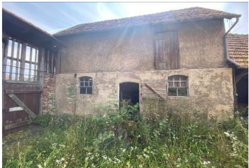
Foto 8 des SV: Ansicht Schweinestall von Nordosten, vom Hof
