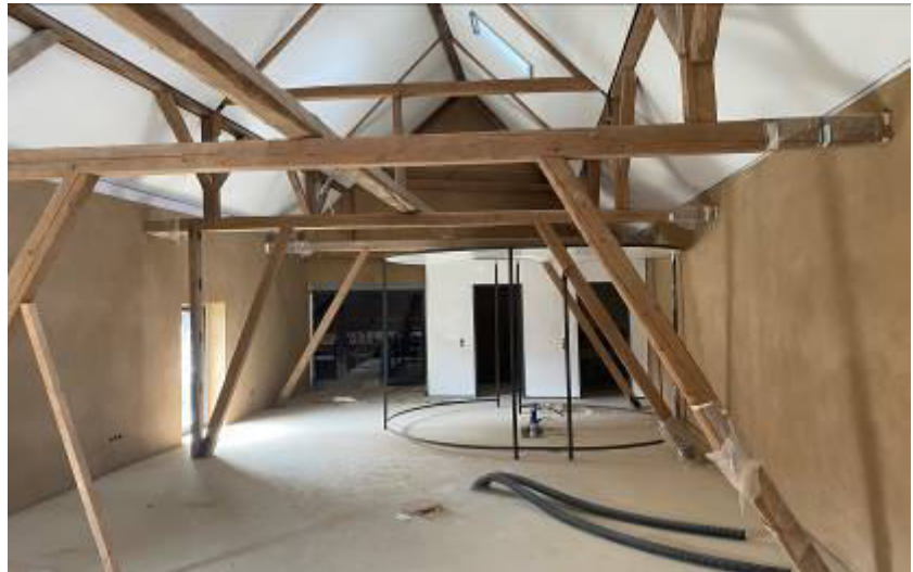
Abb. 21: Foto des SV; z.T. unfertiger Ausbauzustand, fehlende Sanobjekte
