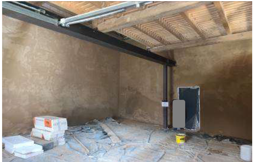
Foto 19 des SV: Ökonomie-/Gewerbegebäude, hinterer Gebäudeteil; EG; Anonymisierung d.d. SV
