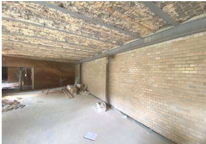
Foto 15 des SV: Ökonomie-/Gewerbegebäude, vorderer Gebäudeteil; EG
