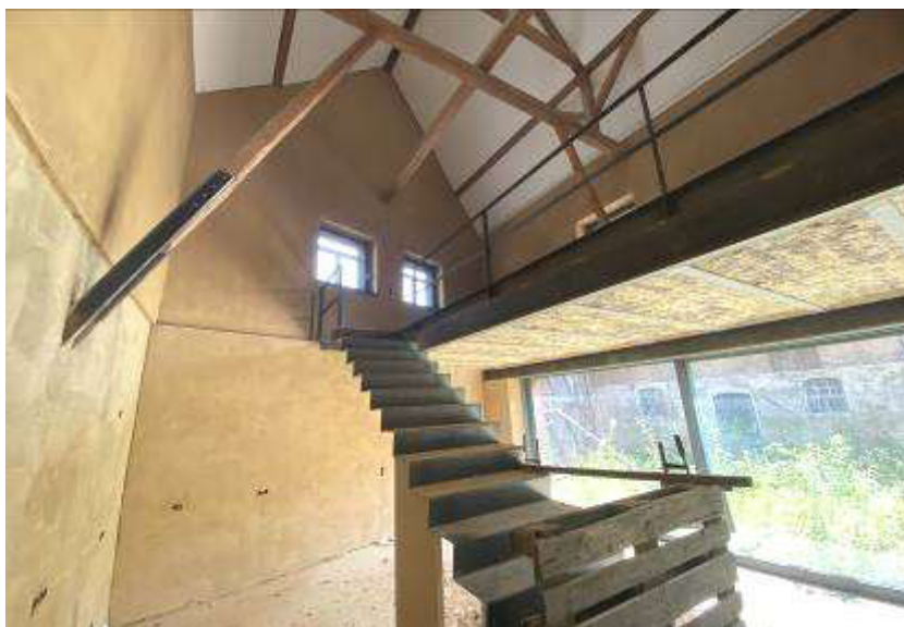
Foto 14 des SV: Ökonomie-/Gewerbegebäude, vorderer Gebäudeteil
