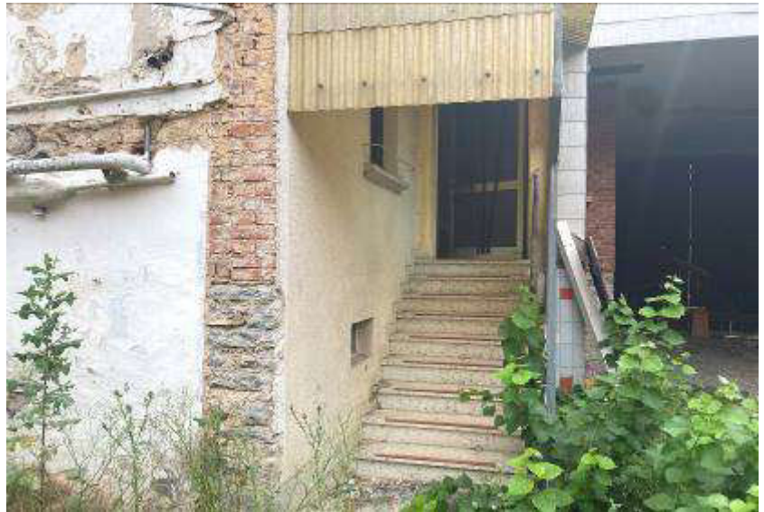
Foto 9 des SV: Wohnhaus, Gebäuderückseite; Hauseingang
