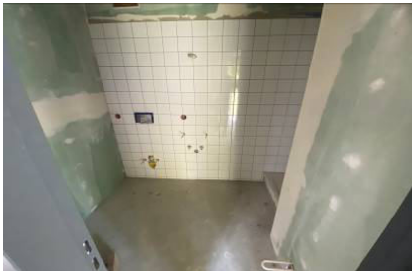
Foto 16 des SV: Ökonomie-/Gewerbegebäude, vorderer Gebäudeteil; EG
