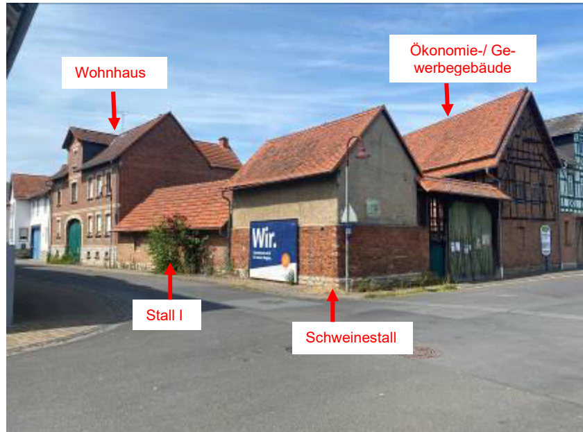
Foto 1 des SV: Übersicht der baulichen Anlagen, Ansicht von Süden; Roteintragungen durch den SV
