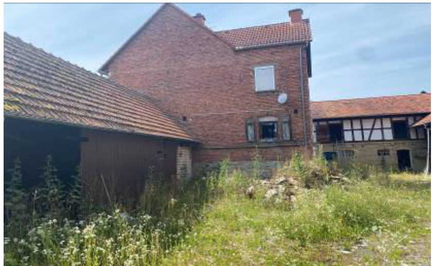
Foto 4 des SV: Ansicht Stall I, Wohnhaus und Stall II/Technik von Osten
