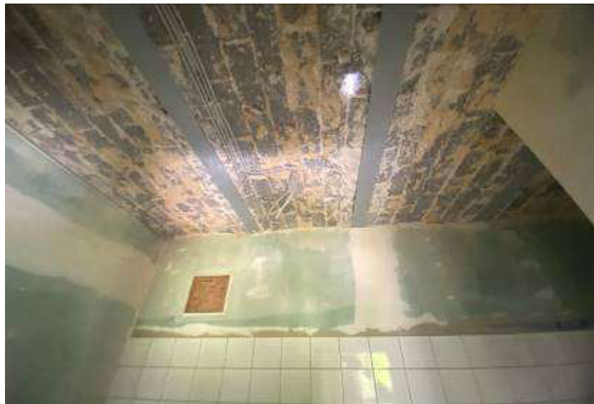
Abb. 18: Foto des SV; z.T. unfertige Wand-/Deckenbekleidungen
