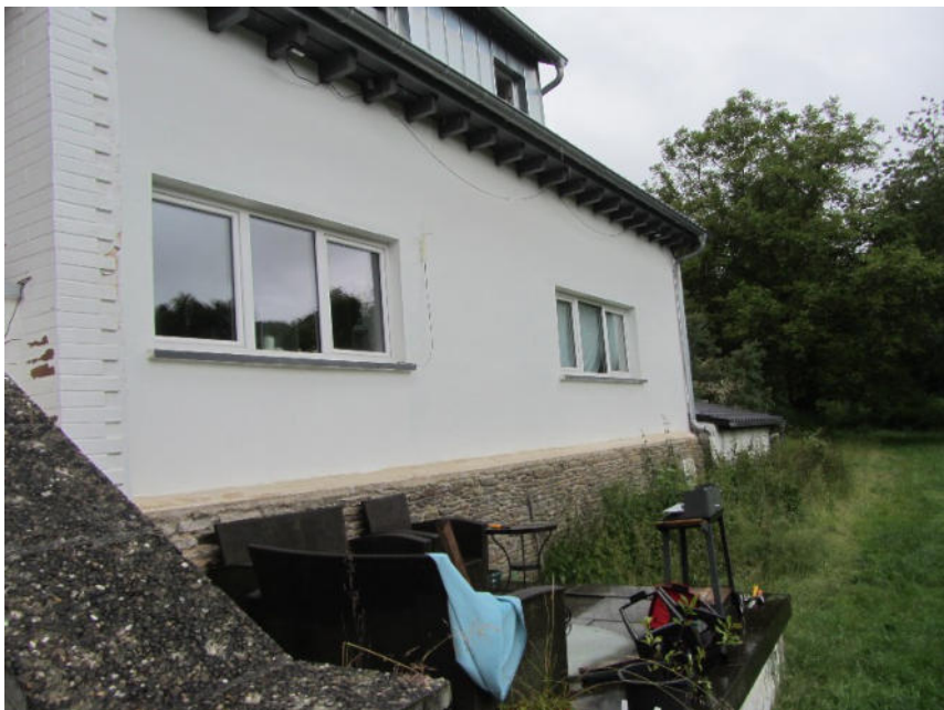
Bild 6: Terrasse neben Eingang zur Gastronomie
