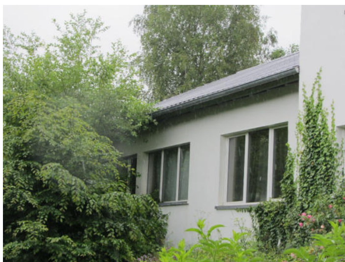
Bild 4: Ansicht Nordost, Wintergarten
