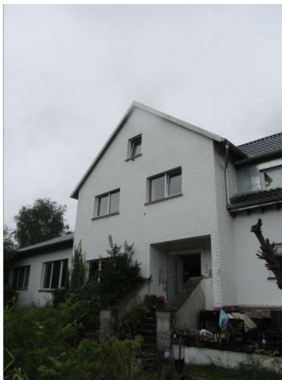
Bild 3: Ansicht Nordost, Eingang Gastronomie
