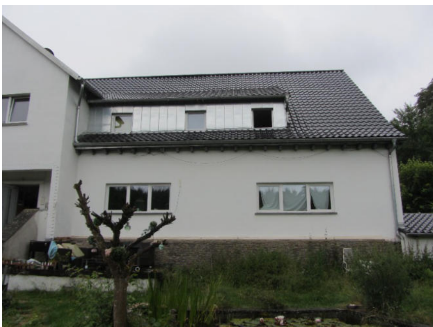
Bild 2: Ansicht Nordost, Gastronomiebereich
