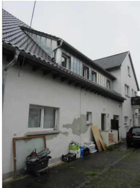
Bild 7: Ansicht Hofseite (Nordwest)
