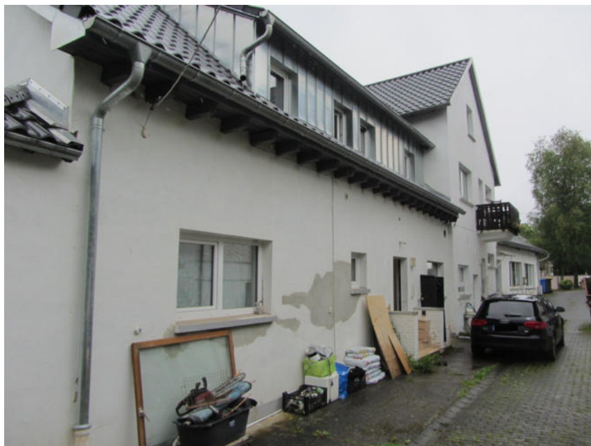
Bild 8: Ansicht Hofseite (Nordwest)
