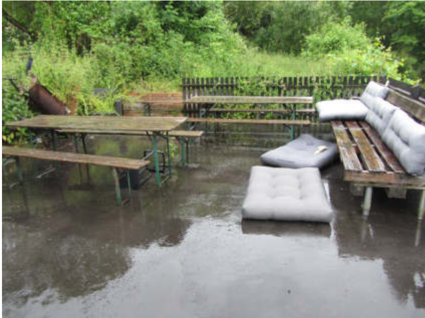
Bild 33: Terrasse auf Garagenanlage
