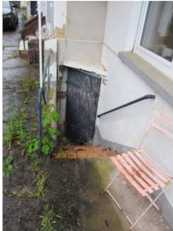
Bild 105: Zugang zu Heizungsraum
