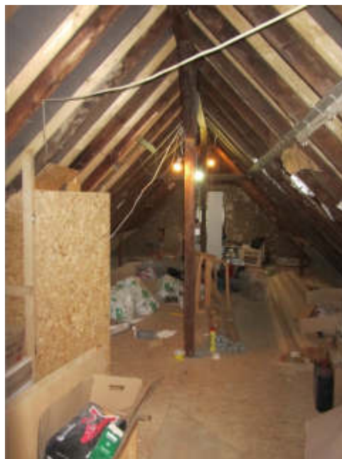
Bild 36: Nicht ausgebautes Dachgeschoss
