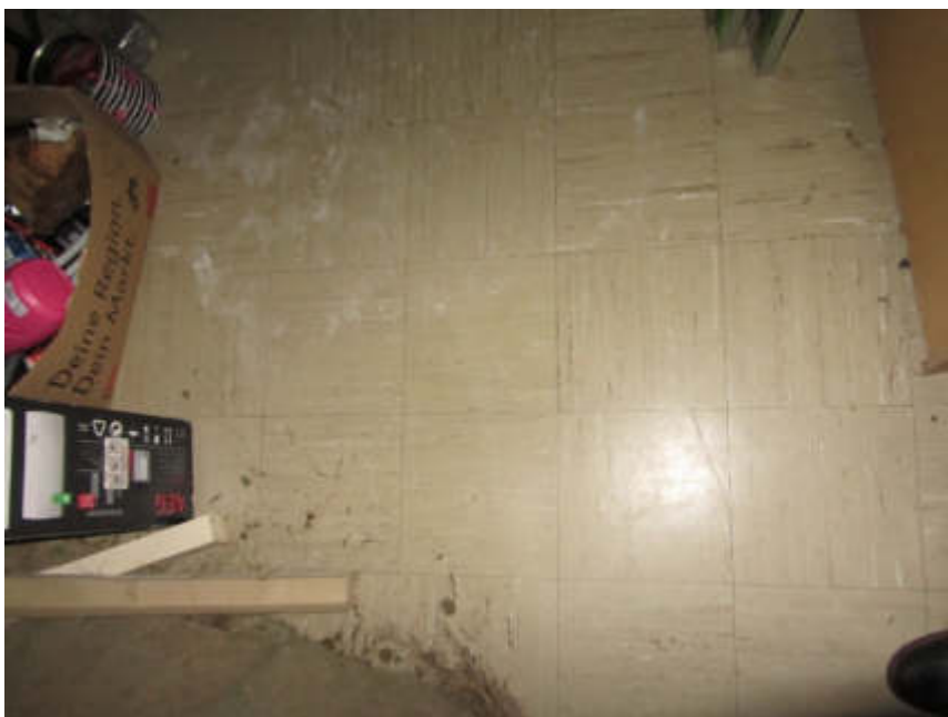
Bild 97: Erdgeschoss: Bodenbelag Wintergarten
