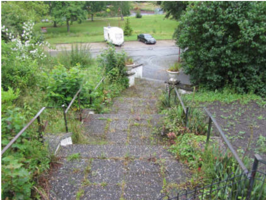
Bild 17: Treppenanlage vor Gastronomiebereich
