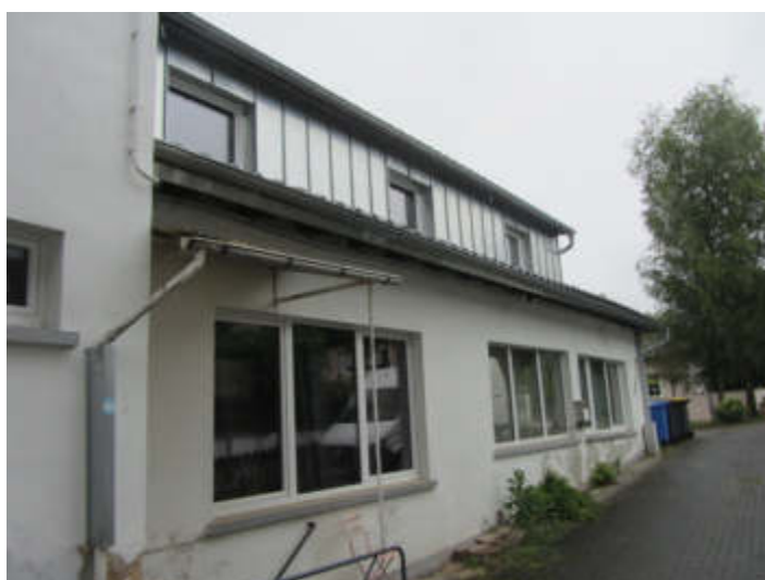
Bild 12: Ansicht Wintergarten (Südwest)
