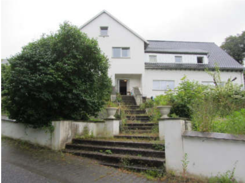
Bild 21: Treppenanlage vor Gastronomiebereich
