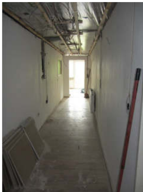
Bild 54: Obergeschoss: Flur Sanierungsfläche
