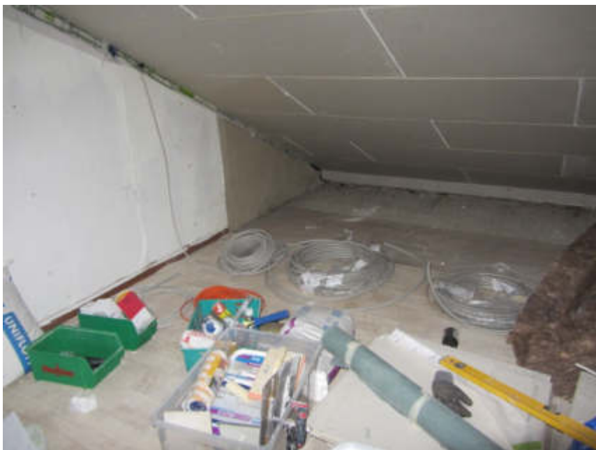
Bild 58: Obergeschoss: Raum unter Dachschräge, Sanierungsfläche
