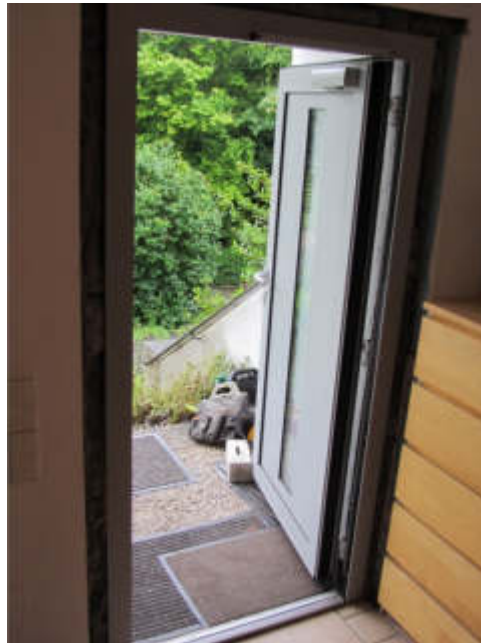
Bild 101: Erdgeschoss: Eingangstüre Gastronomiebereich
