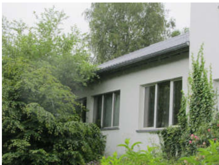
Bild 4: Ansicht Nordost, Wintergarten
