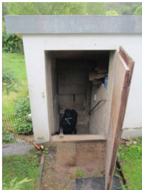
Bild 102: Zugang zu Keller über Anbau
