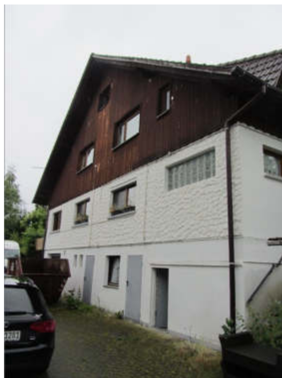
Bild 14: Nachbargebäude Nr. 1a
