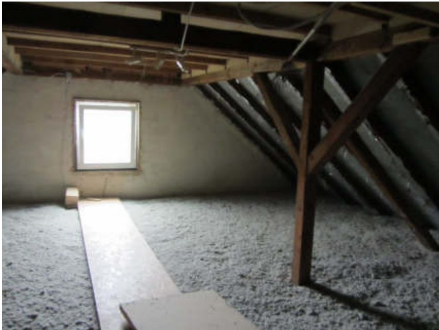
Bild 35: Nicht ausgebautes Dachgeschoss
