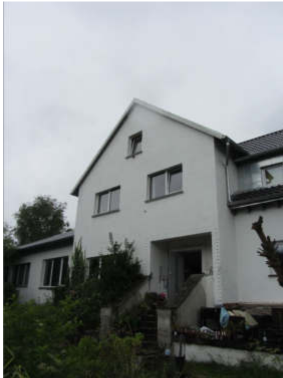
Bild 3: Ansicht Nordost, Eingang Gastronomie
