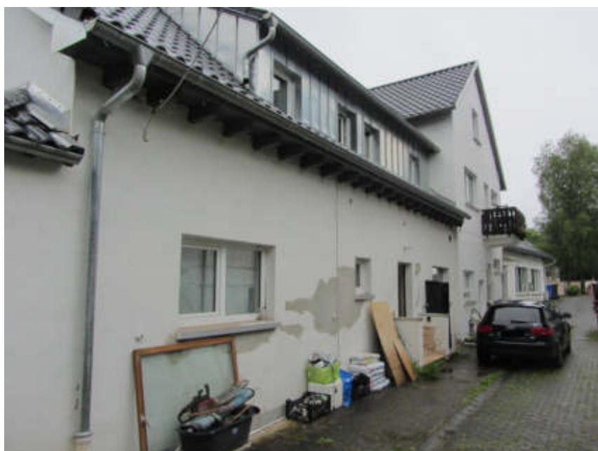
Bild 10: Ansicht Hofseite (Nordwest)
