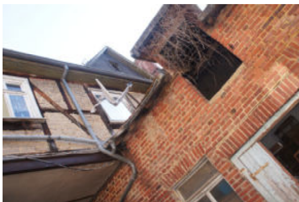
Gebäude B Torhaus links, Gebäude C rechts
