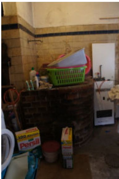
ehem. Räucherei, mit ehem. Kochbereich
