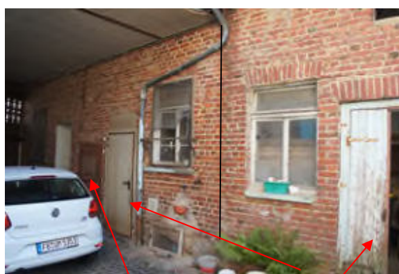
Gebäude C (ehem. Metzgerei, Kellerabgangstreppe, ehem. Räucherei) und Gebäude D (ehem. Schlachtereie)
