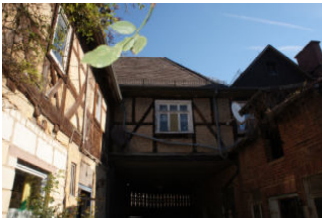
Gebäude A Außenansicht Nordwest, links, davon 1.OG über dem Torhaus dem Gebäude B und ganz rechts über Gebäude C
