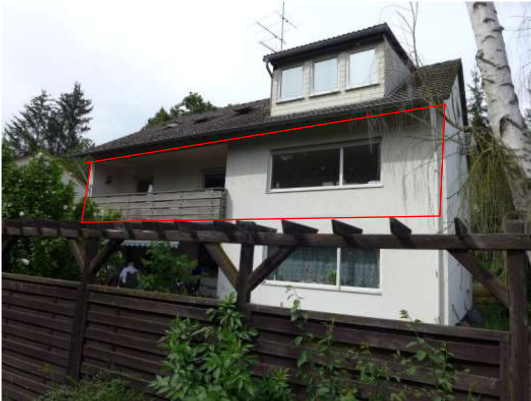
3 Straßenansicht (Südansicht), Lage des Objekts Wohnung Nr. 2
