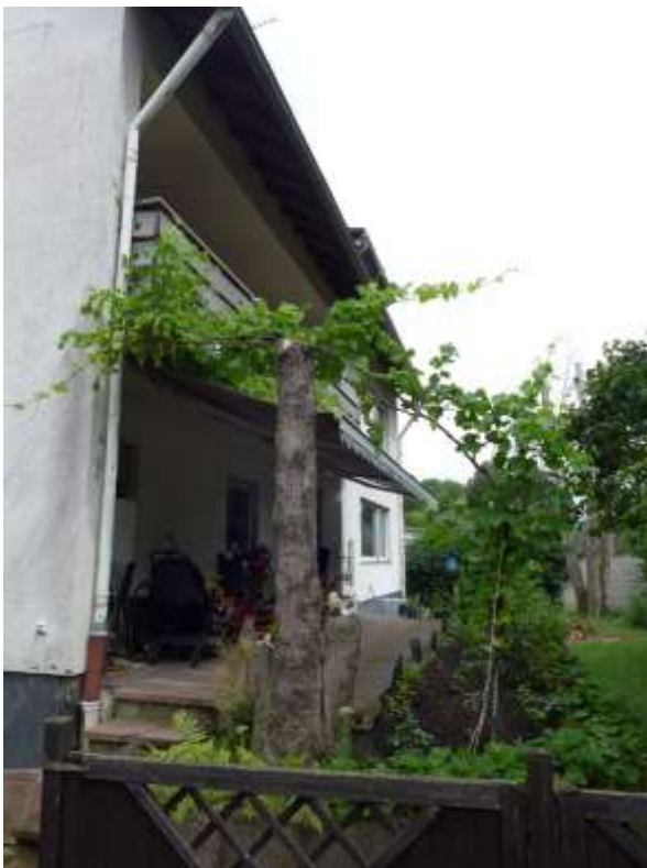
6 a Südseite Freifläche (SNR Whg. Nr. 1)
