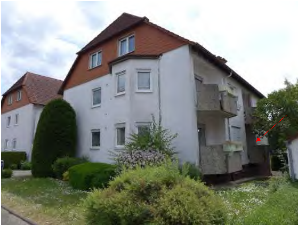
7 Nordwestansicht Wohnhaus B, Lage des Bewertungsobjekts
