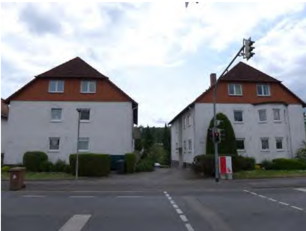
2 Nordansicht beider Wohnhäuser A (links) und B (rechts)
