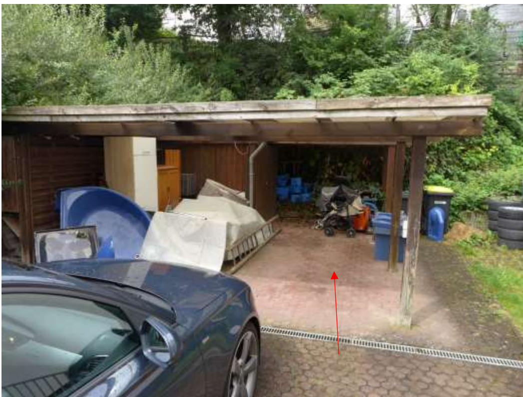
10 Carport mit SNR an Stellplatzflächen für Whg. Nr. 2 und Whg. Nr. 1 (markiert)
