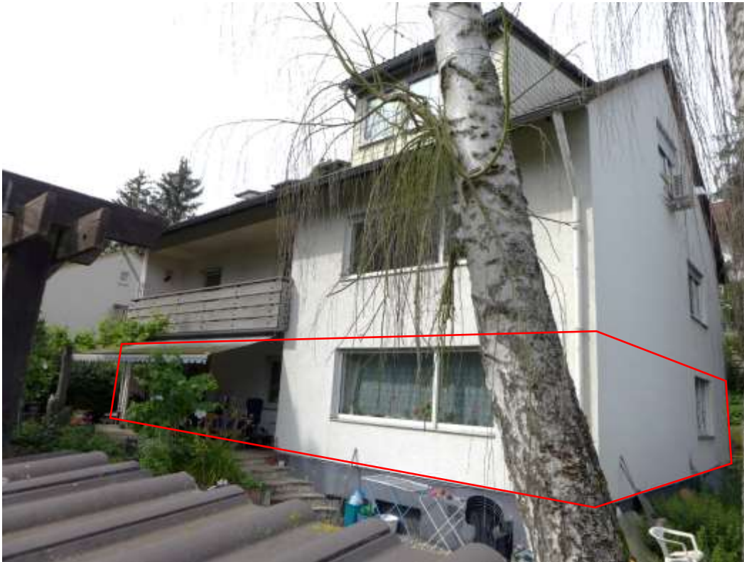
5 Südansicht, Lage des Objekts Wohnung Nr. 1
