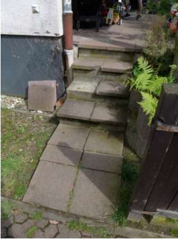
17 Terrassenzugang vom Hof
