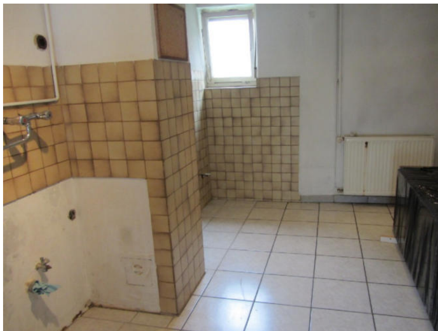
Bild 22: EG Wohngebäude, Küche
