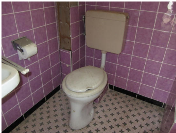
Bild 10: EG Wohngebäude, Bad
