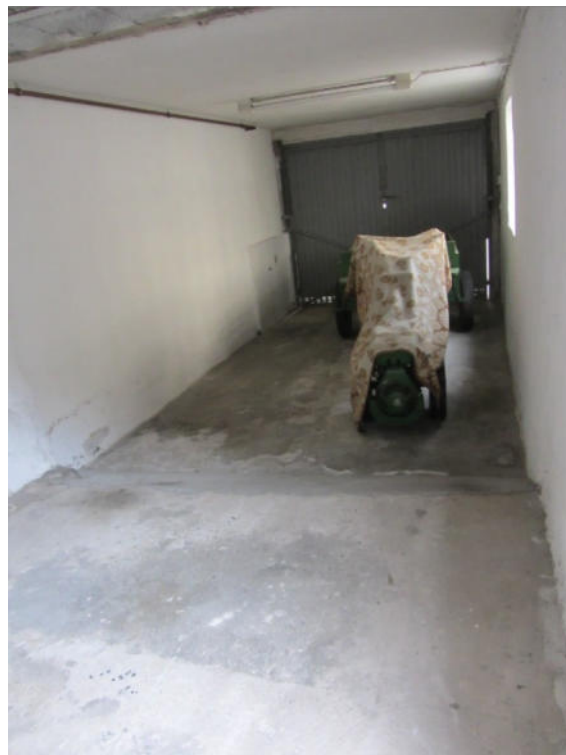
Bild 42: EG Nebengebäude, Garage
