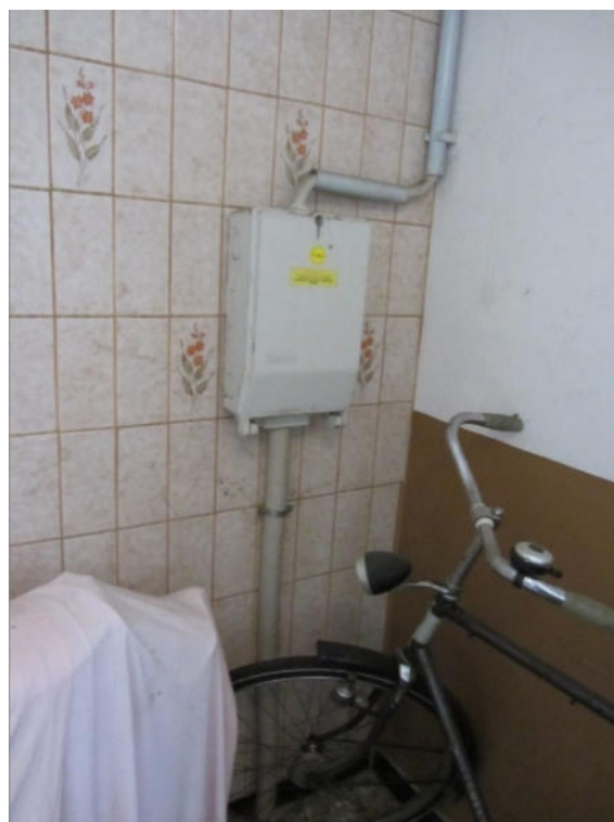
Bild 16: EG Wohngebäude, Abstellraum
