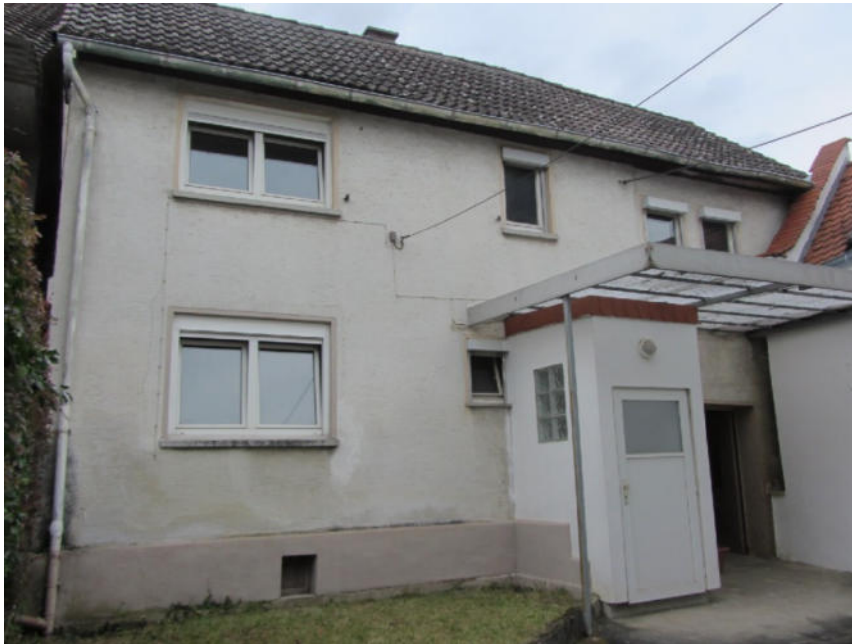
Bild 1: Ansicht Süd, Wohngebäude
