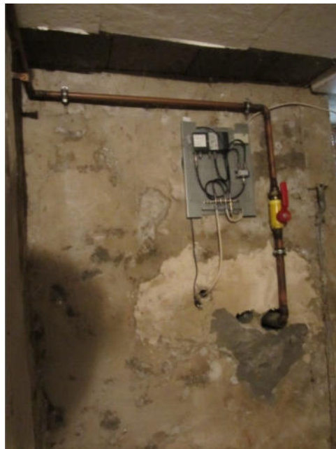
Bild 14: KG Wohngebäude, Hausanschluss Gas
