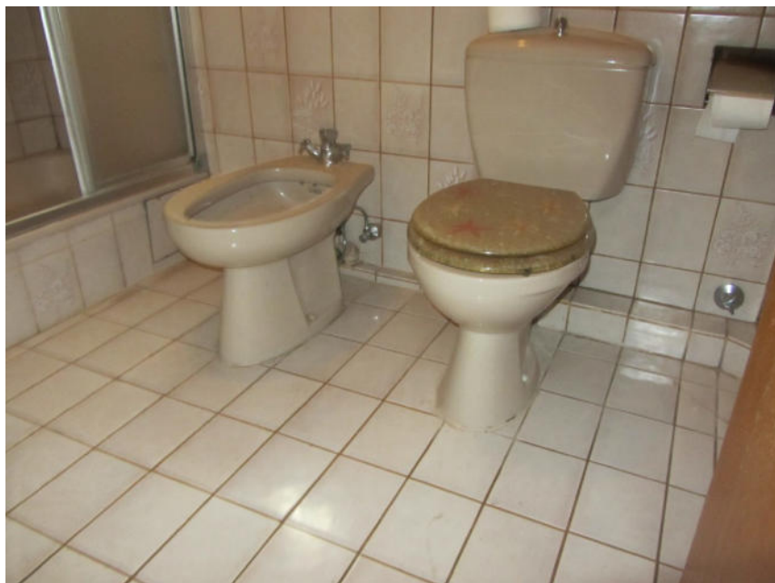
Bild 30: OG Wohngebäude, Bad
