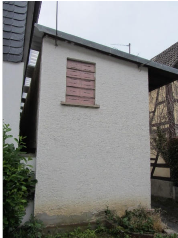
Bild 3: Ansicht Nord, Nebengebäude
