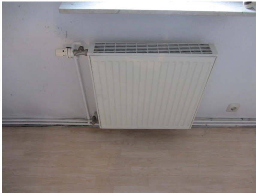
Bild 28: OG Wohngebäude, Zustand Heizkörper
