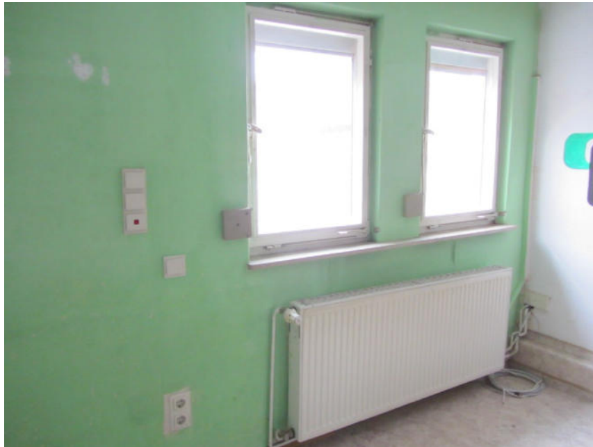
Bild 33: OG Wohngebäude, Zimmer 01
