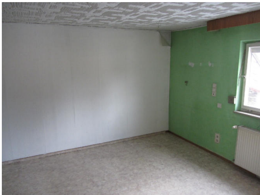
Bild 32: OG Wohngebäude, Zimmer 01
