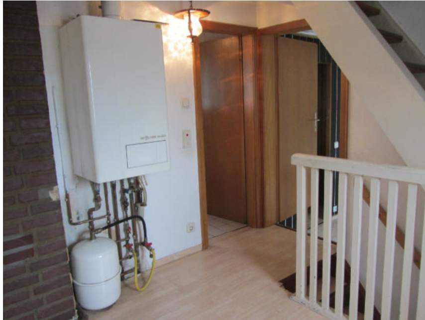
Bild 25: OG Wohngebäude, Flur
