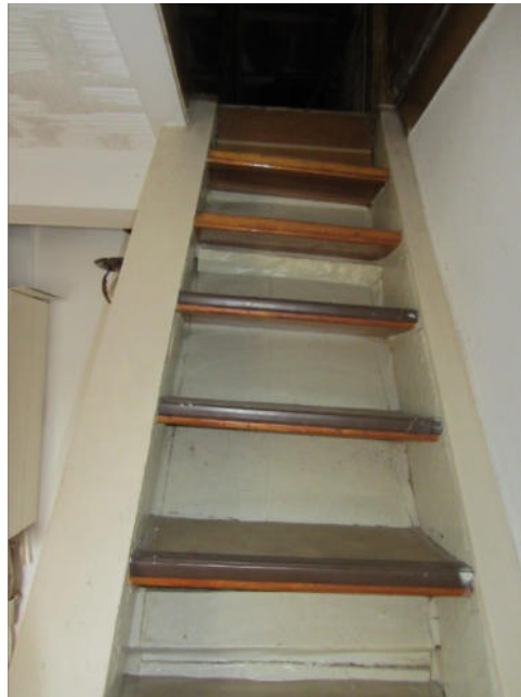
Bild 37: OG Wohngebäude, Treppe zu DG
