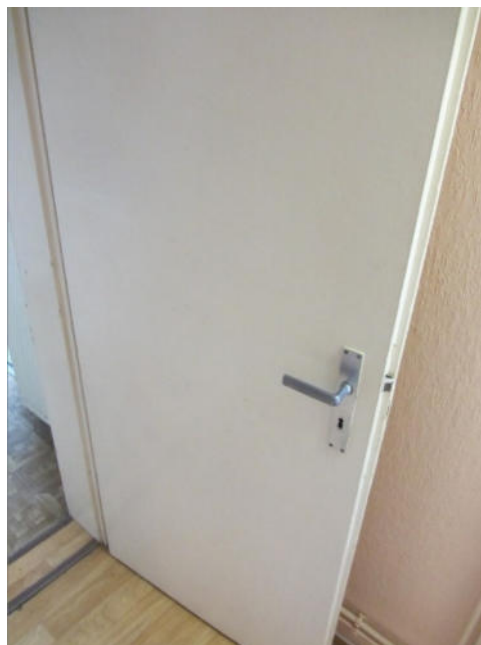
Bild 20: EG Wohngebäude, Zustand Innentüren
