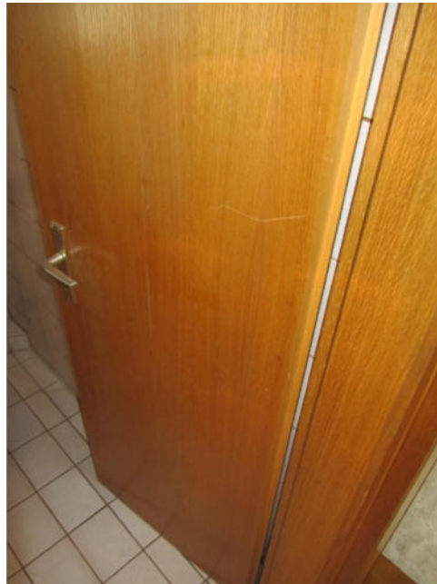
Bild 31: OG Wohngebäude, Zustand Innentüren
