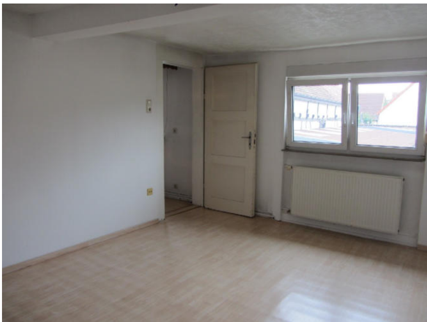
Bild 36: OG Wohngebäude, Zimmer 02
