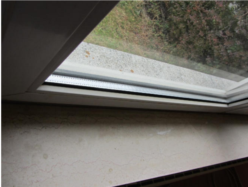
Bild 19: EG Wohngebäude, Zustand Fenster
