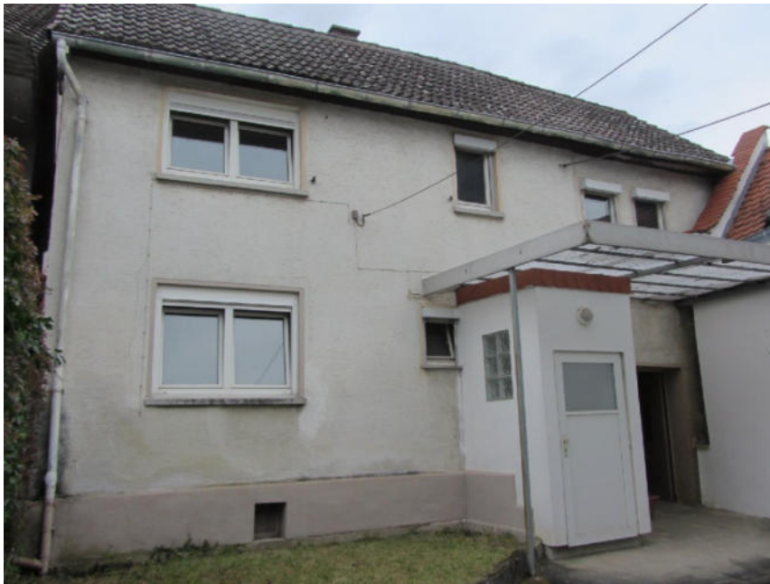
Bild 1: Ansicht Süd, Wohngebäude
