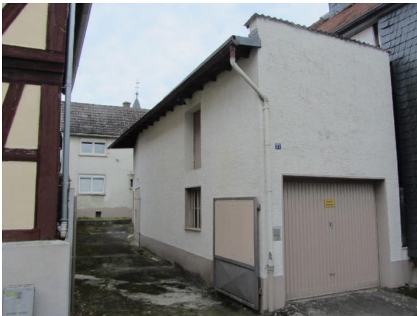
Bild 2: Ansicht Südwest, Nebengebäude
