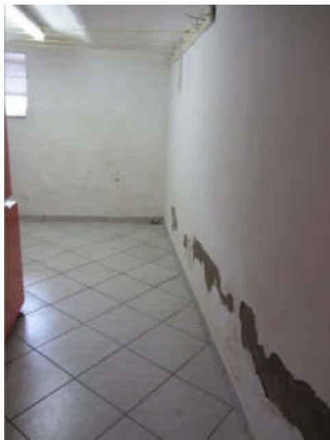
Bild 26: KG unter Wohnhaus: Zustand Kellerwände mit Nässeschäden
