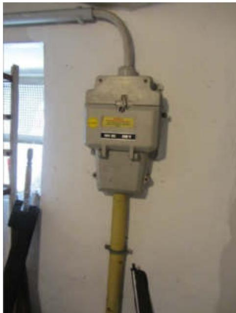
Bild 30: KG unter Wohnhaus: Hausanschluss Strom
