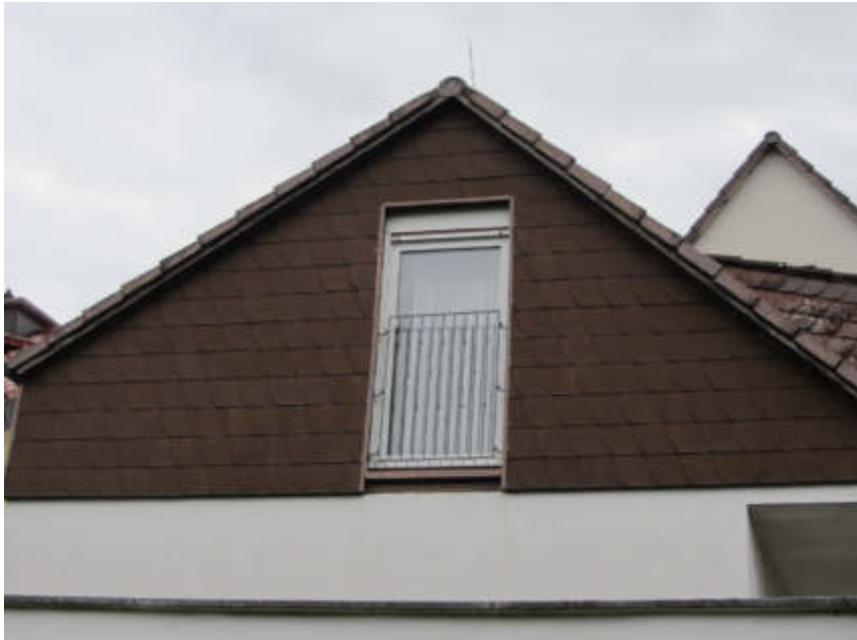
Bild 7: Vermutlich asbesthaltige Giebelwandverkleidung
