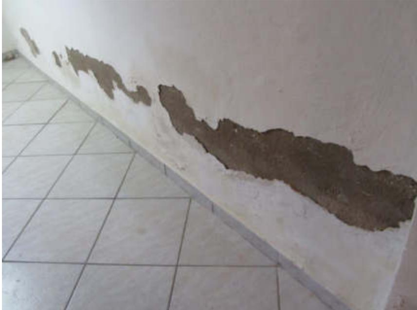
Bild 27: KG unter Wohnhaus: Zustand Kellerwände mit Nässeschäden
