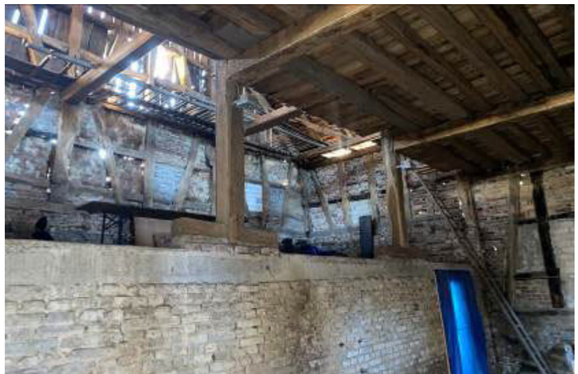
Foto 16 des SV: Scheune
