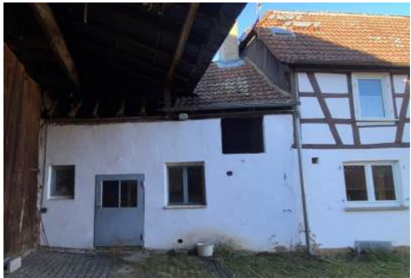
Foto 4 des SV: Ansicht des Wohnhausanbaus von Süden
