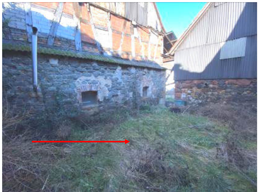
Foto 21 des SV: Ansicht von Südwesten
