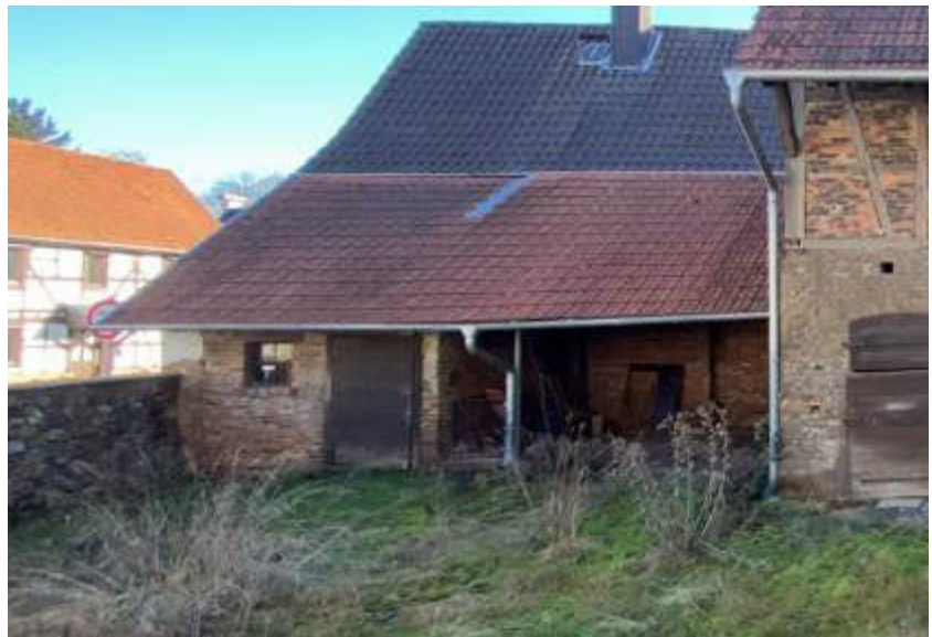
Foto 18 des SV: Ansicht Schuppen von Norden
