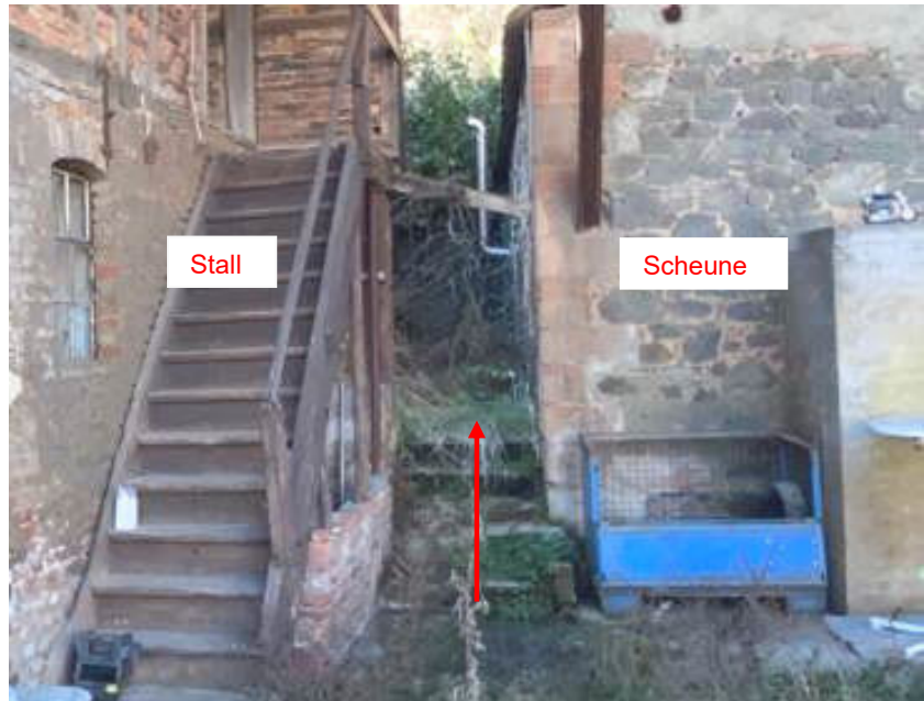
Foto 20 des SV: Zugang zum unbebauten Grundstück Flst. 287, Ansicht vom Hof Flst. 288
