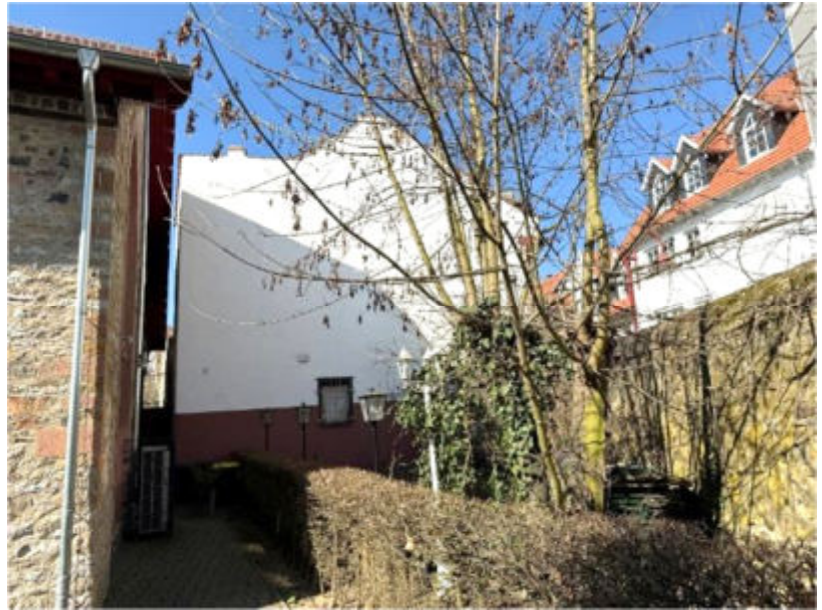
Foto 13 des SV: Ansicht von Osten, Außenbereich (Biergarten)
