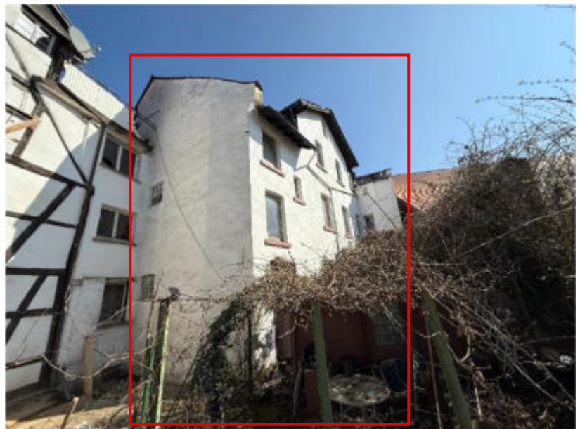
Foto 2 des SV: Ansicht von Südwesten, Gebäuderückseite
