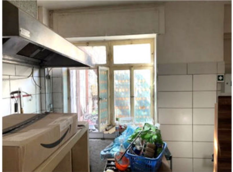
Foto 7 des SV: EG, Gaststätte, Küche
