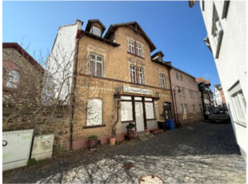
Foto 1 des SV: Ansicht von Nordosten; Gebäudevorderseite (Eingänge), Straßenansicht
