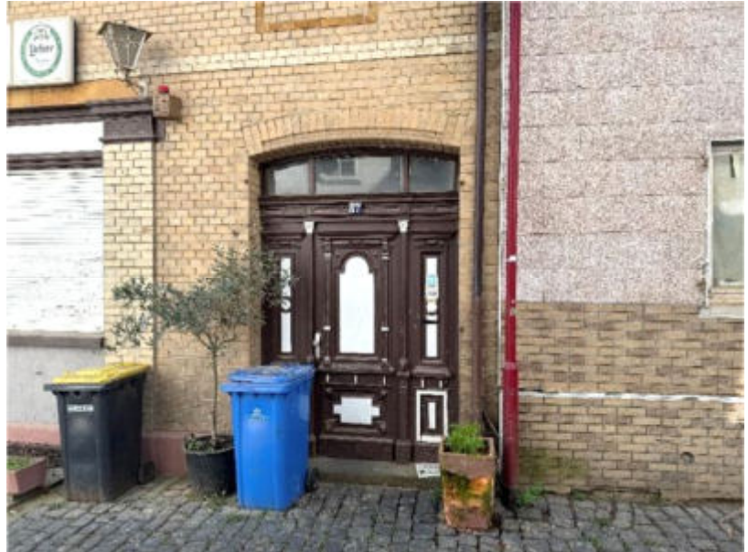
Foto 3 des SV: Gebäudeeingang, Ansicht Norden
