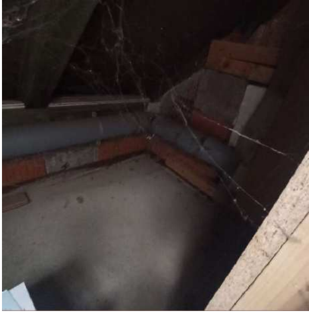
Blick in den Abseitenbereich
