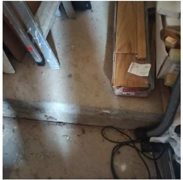
Absatz im DG über dem Kaminzimmer
