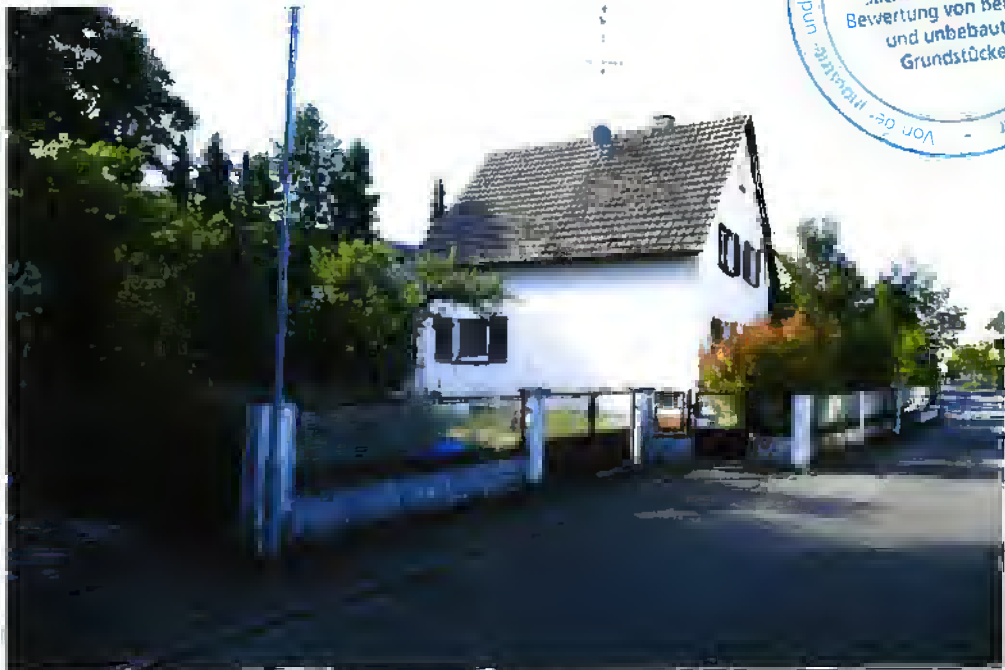
Bild 2: Ansicht von Süd-Osten
