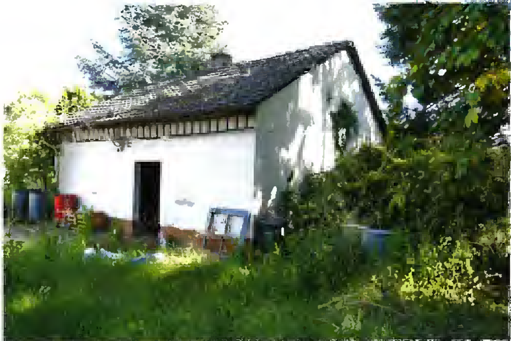
Bild 4: Blick von Nord-Westen auf das Nebengebäude
