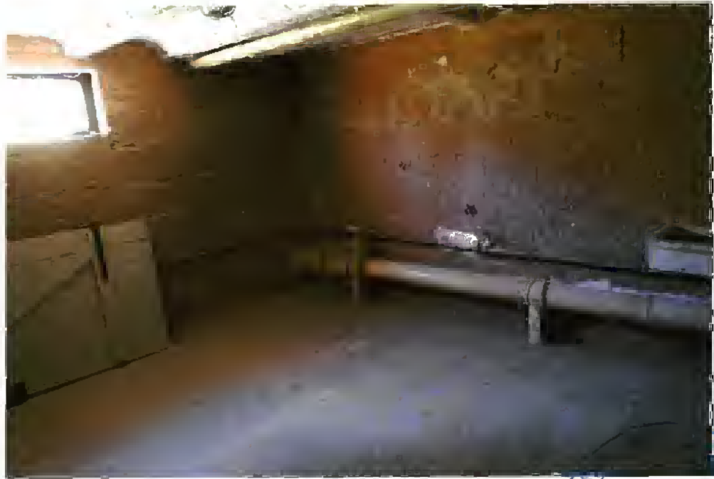
Bild 5: Blick in das Kellergeschoss
