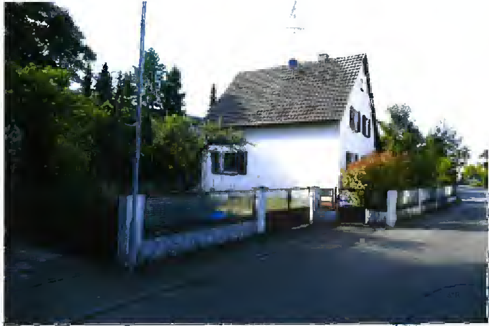
Bild 9: Blick von Süd-Osten. Die Zufahrt und das Zufahrtstor sowie der südliche Bereich der straßenseitigen Einfriedung müssen rückversetzt werden (vgl. Ziff. 3.21)
