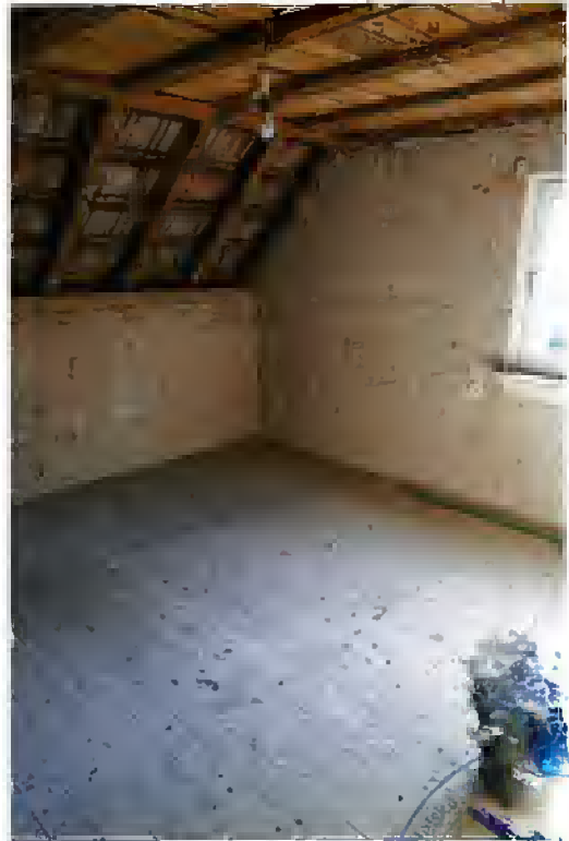
Bild 7: Blick in das Obergeschoss
