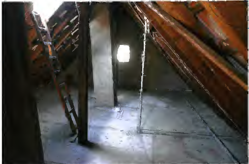
Bild 8: Blick in den Spitzboden
