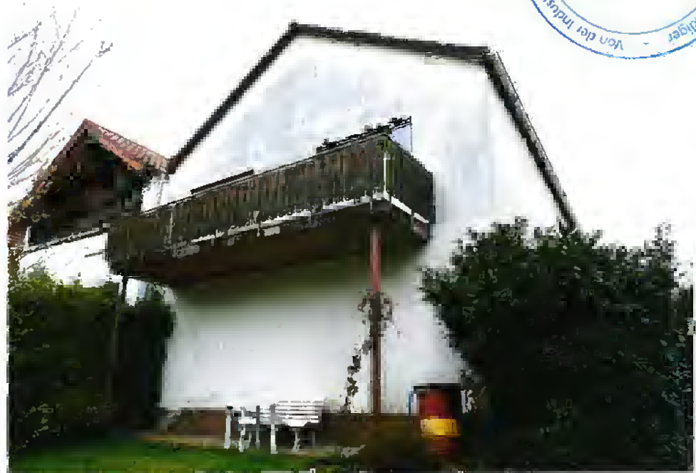
Bild 8: Balkongeländer sanierungsbedürftig
