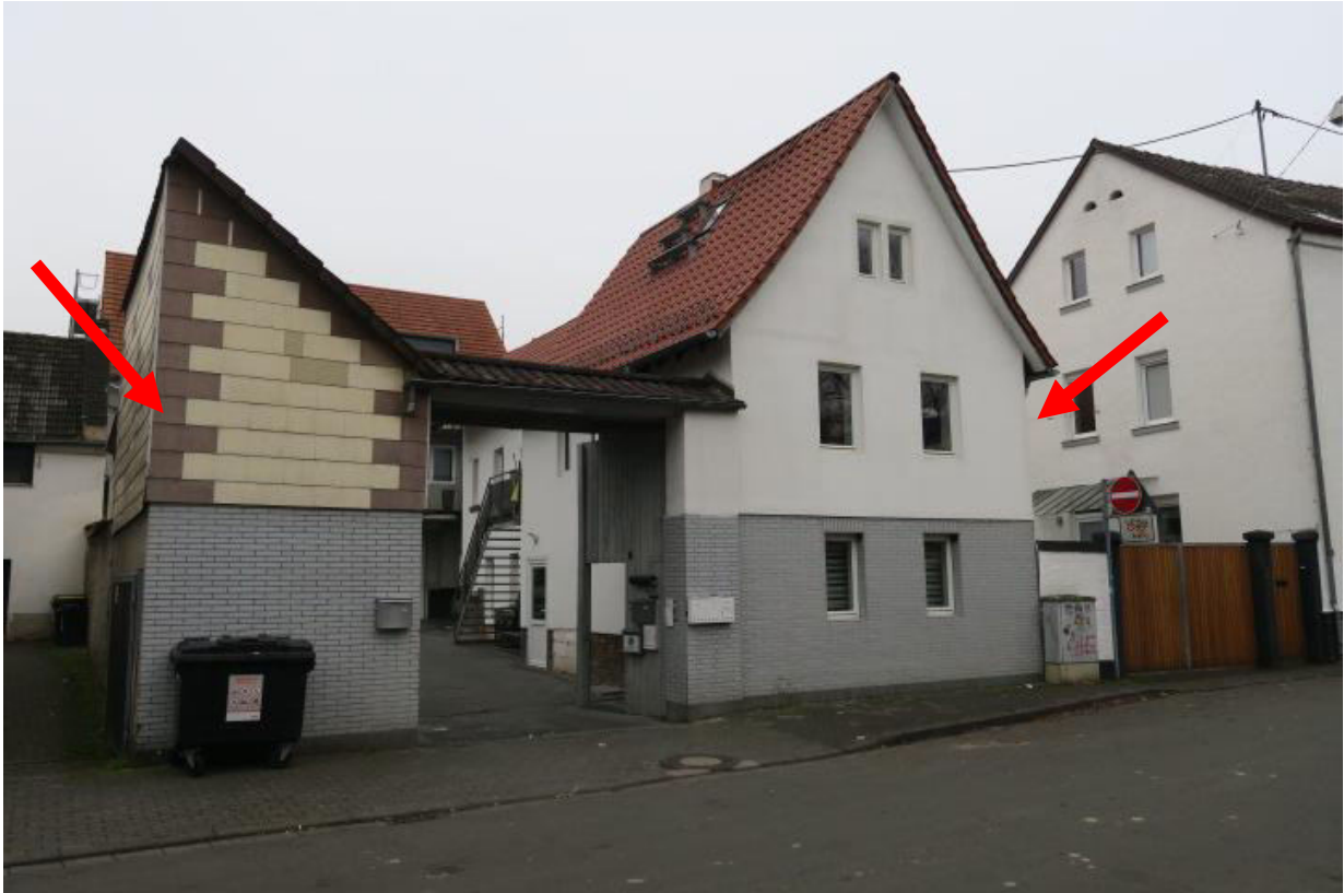
Foto1: Ansicht des Zweifamilienhauses von der Aunelstraße
