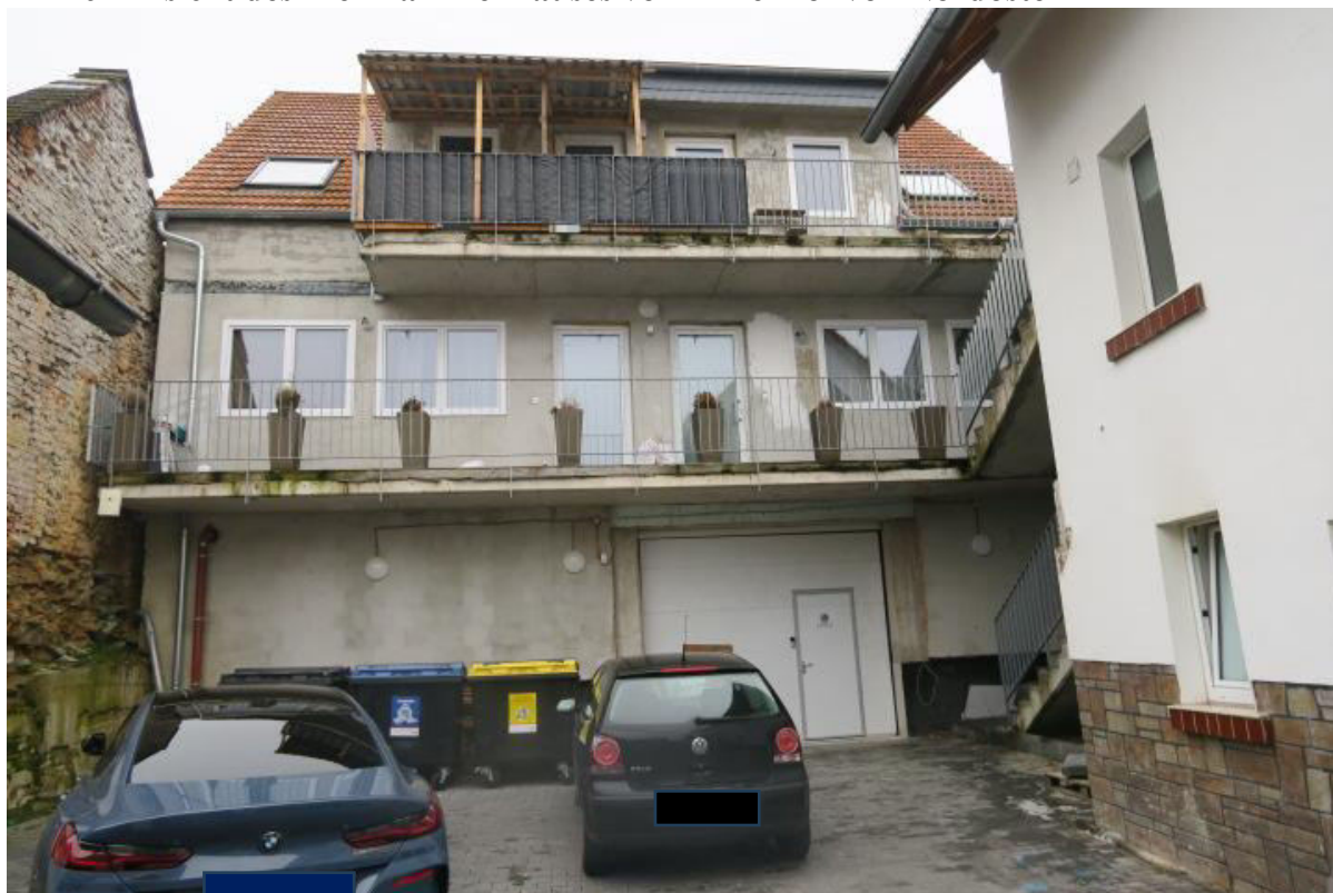
Foto 6: Ansicht des Mehrfamilienhauses vom Innenhof von Nordosten
