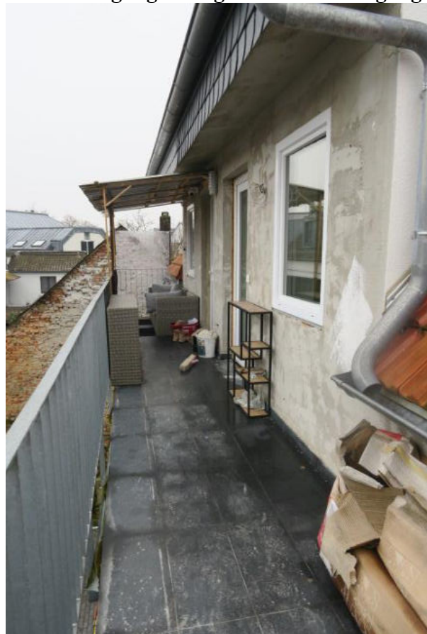
Foto 10: Zugang Dachgeschoss Laubengang
