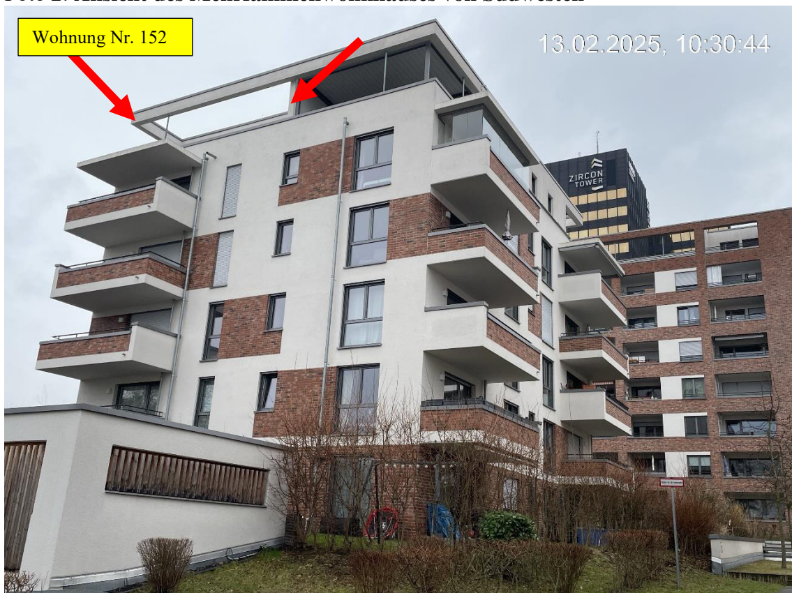
Foto 2: Ansicht des Mehrfamilienwohnhauses von Südwesten
